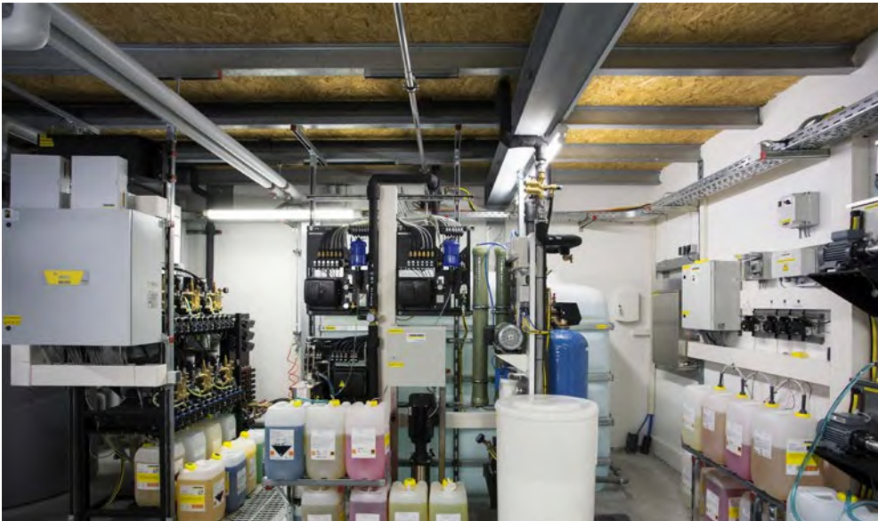
Abb. 6 Zu den Nebenräumen bei Fahrzeugwaschanlagen zählen z. B. Lager für Waschchemie und Technik- bzw. Kompressorraum.
