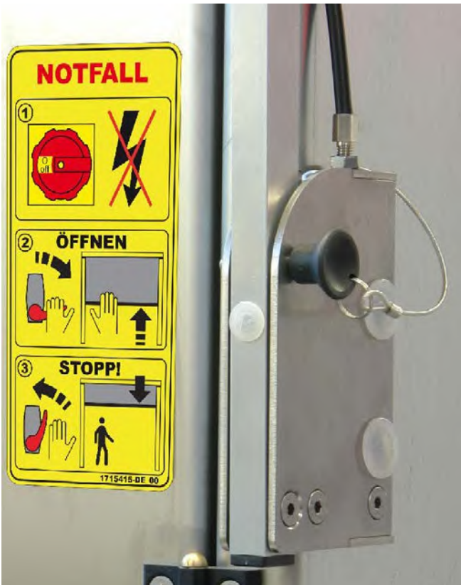
Abb. 5 Notbetätigung an einem Waschhallentor
