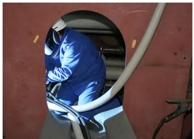
Abb. 26 Lichtbogenschweißer unter erhöhter elektrischer Gefährdung im leitfähigen Bereich mit begrenzter Bewegungsfreiheit
