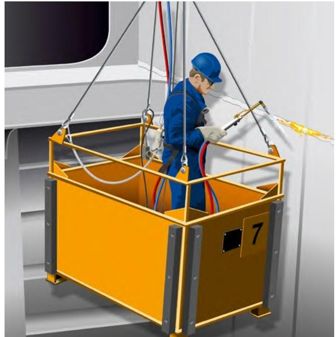
Abb. 15 Hochziehbares Personenaufnahmemittel am Kran hängend
