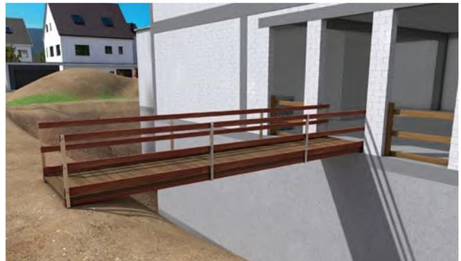
Abb. 7 Laufsteg mit Trittleisten (wegen Rutschgefahr) und Seitenschutz
