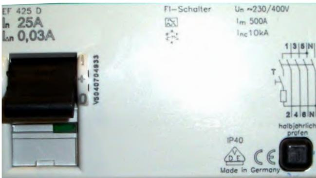
Abb. 19 FI-Schutzschalter für einen Baustromverteiler
