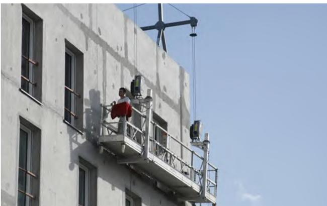
Abb. 14 Hochziehbares Personenaufnahmemittel bei Arbeiten an einer Fassade
