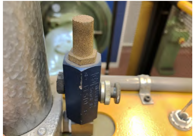
Abb. 26 Sintermetall-Schalldämpfer an pneumatischer Steuerung
