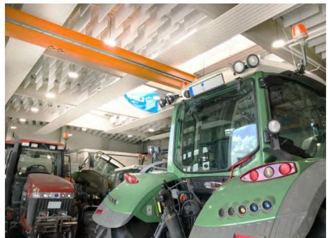
Abb. 37 Nachträglich mit Baffeln raumakustisch verbesserte Werkstatt
