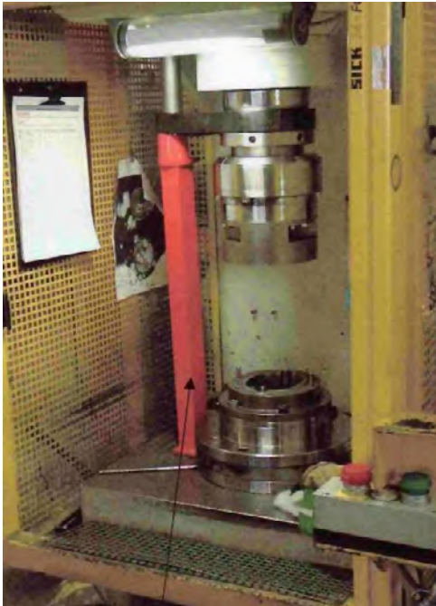
Abb. 28 Eingesetzte Abstützung an einer hydraulischen Presse
