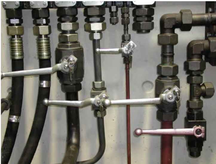
Abb. 3 Sichern gegen Wiedereinschalten durch abschließbare Kugelhähne
