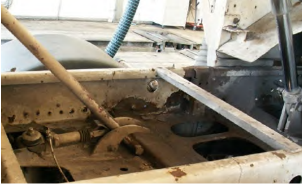
Abb. 37 Sicherungsstütze an einem hydraulisch angehobenen Fahrzeugaufbau
