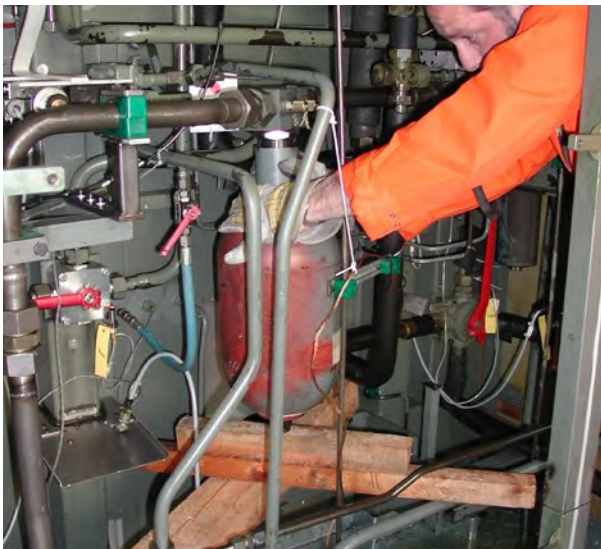
Abb. 1 Instandhalter bei Wartungsarbeiten
