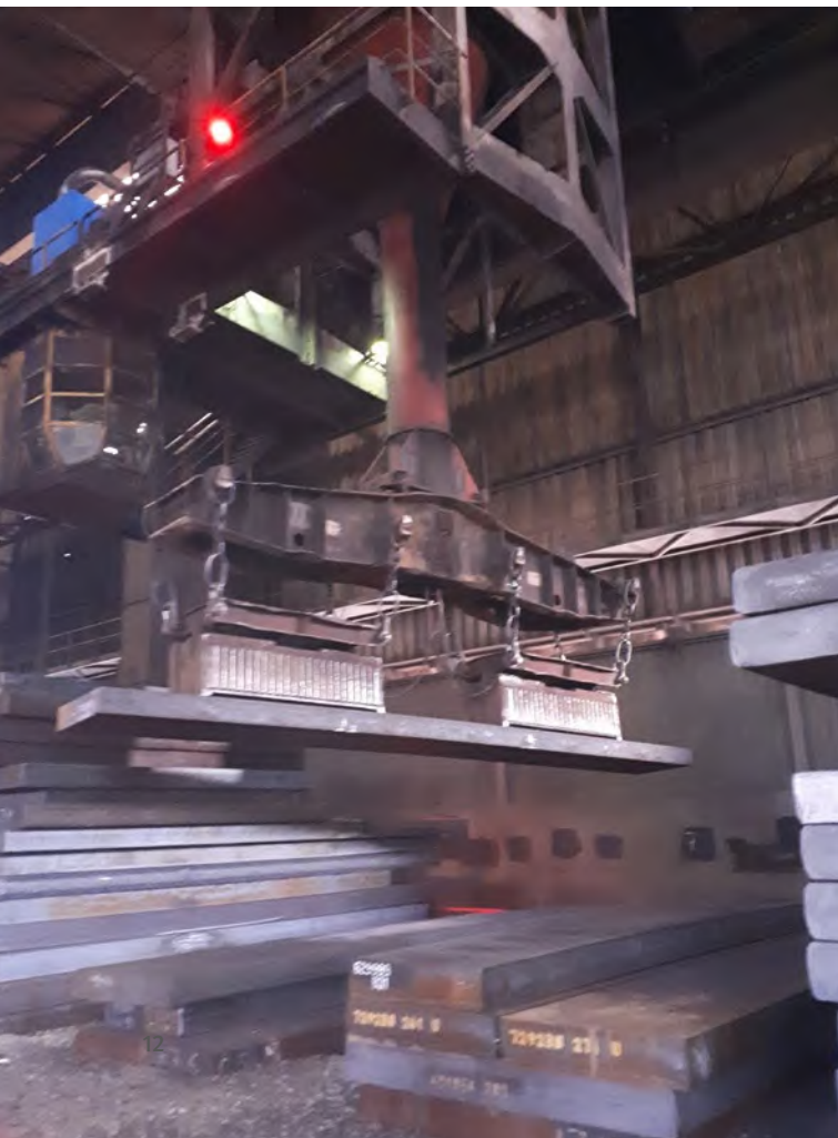
Abb. 6 Brammentransportkran mit Magnet
