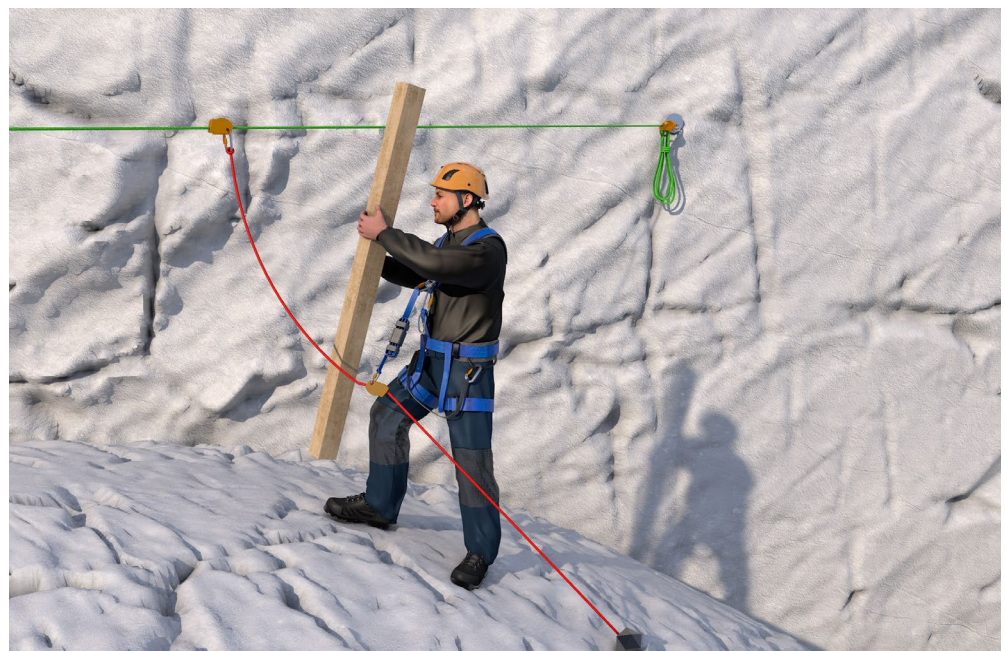
Abb. 6 Verwendung von PSAgA/Auffangsystem
