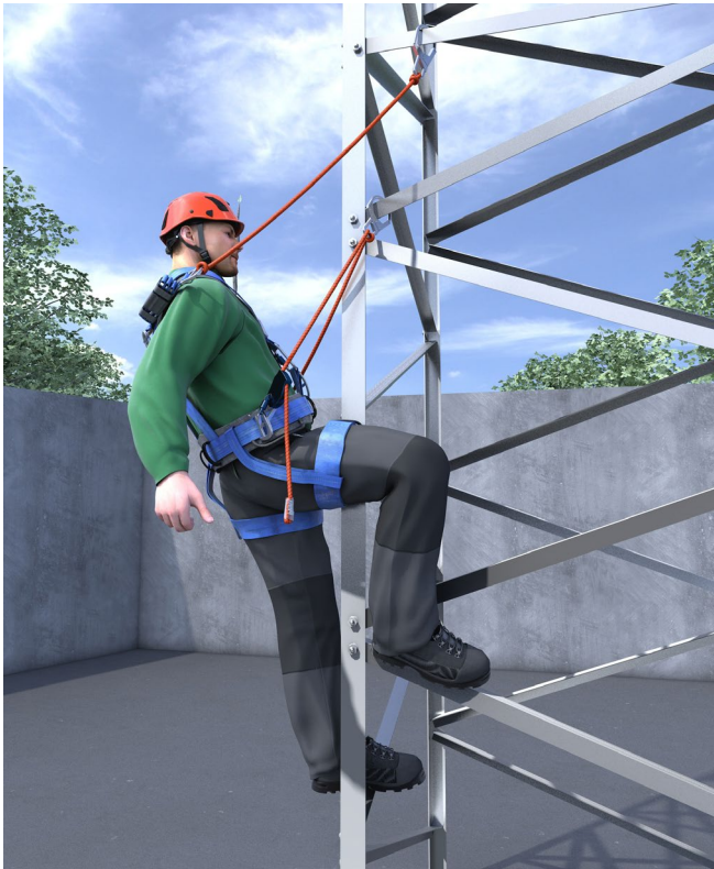
Abb. 8 Positionieren durch Verwendung von PSAgA
