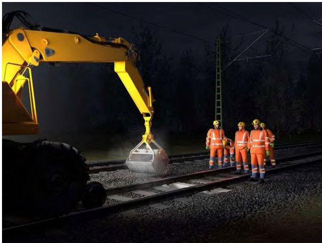
Abb. 22 Gleisoberbauarbeiten: Empfehlung Warnkleidung Klasse 3
