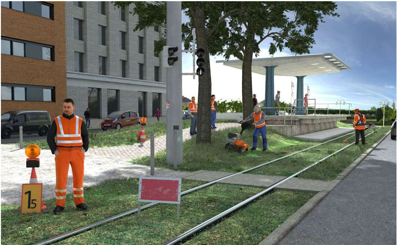
Abb. 25 Vegetationspflegearbeiten im Gleisbereich von Straßenbahnen: mindestens Warnkleidung Klasse 2
