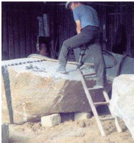
Abb. 33: Sicherer Zugang und Unterfütterung des Rohblocks
