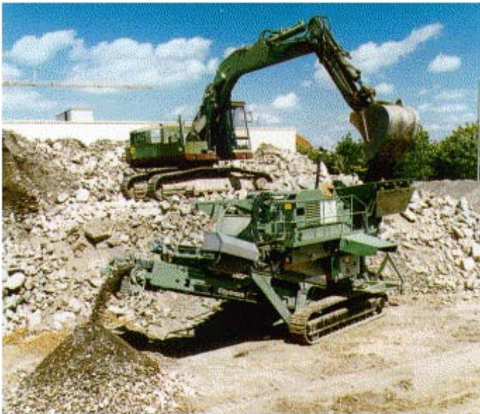
Abb. 17: Beispiel für die erhöhte Aufstellung des Baggers
