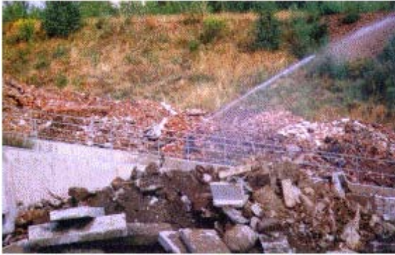
Abb. 9: Künstliche Berieselung von Bauschutt
