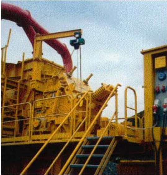
Abb. 21: Treppenaufgang und Montagekran
