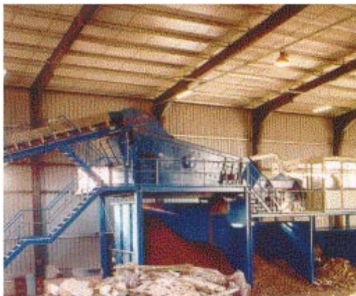
Abb. 7: Beleuchtung einer Recyclinganlage in einer Halle
