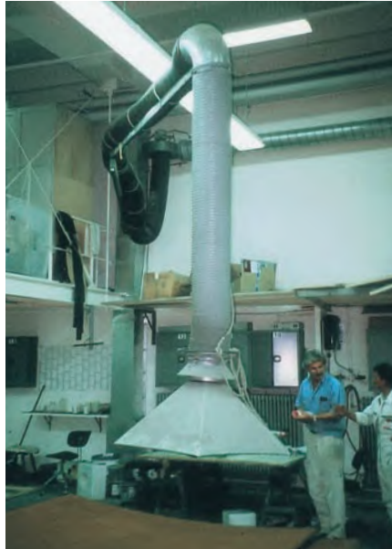
Abbildung 5: Flexible Punktabsaugung für Flächen (Overmann)
