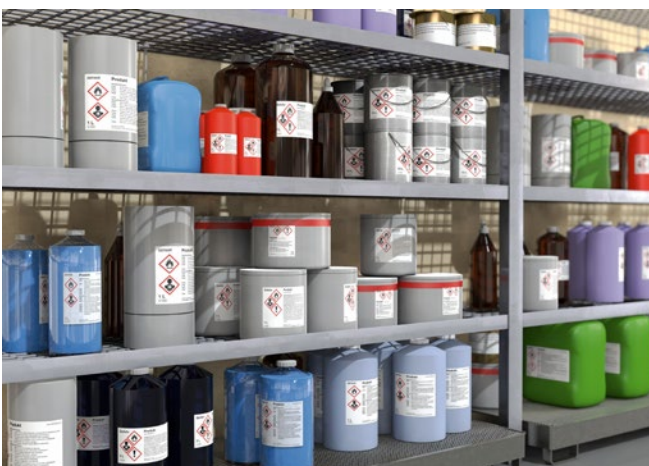
Abb. 3 Lagerraum für entzündbare Flüssigkeiten
