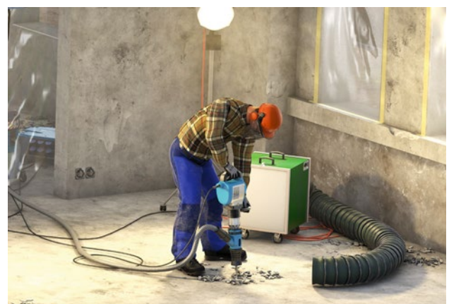
Abb. 13 und 14 Verwendung geprüfter, abgesaugter Bearbeitungssysteme
