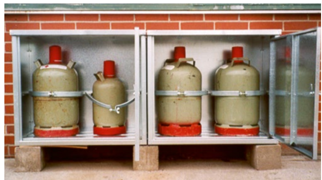
Abb. 5 Kleinelager für Flüssiggasflaschen
