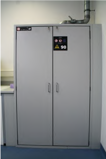
Abb. 17 Lagerung entzündbarer Flüssigkeiten im Sicherheits-schrank (explosionsgeschützte Lagerung)
