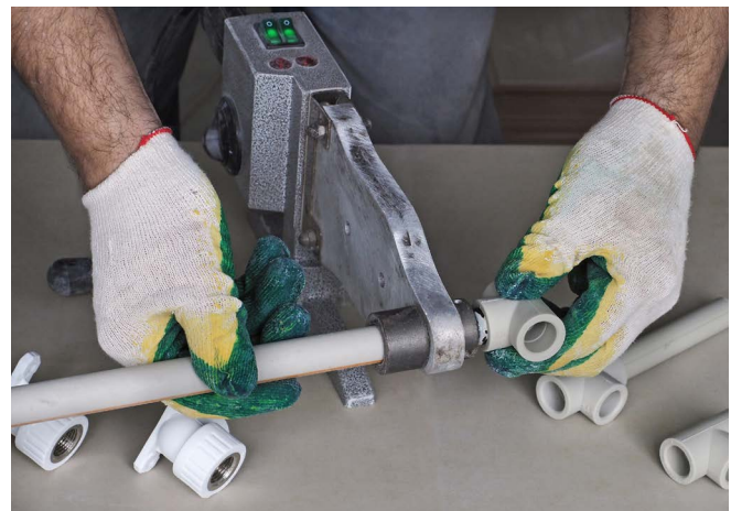
Abb. 34 Heißschweißen von PVC-Rohren
