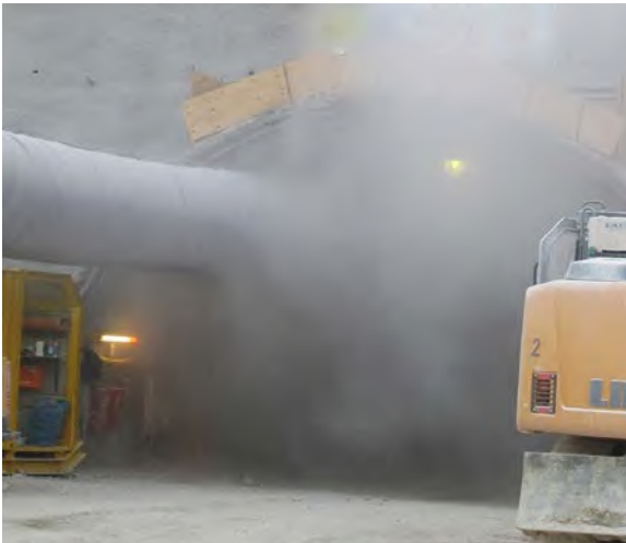
Abb. 40 Abziehende Sprengschwaden am Tunnelportal
