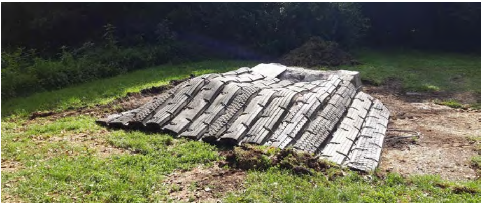
Abb. 32 Einsatz einer Sprengschuttmatte
