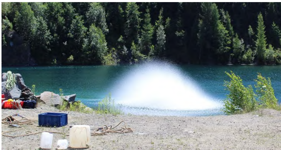
Abb. 42 Sprengung unter Wasser
