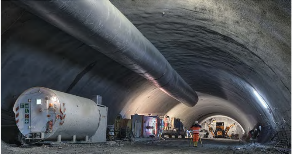
Abb. 39 Drückende Belüftung
