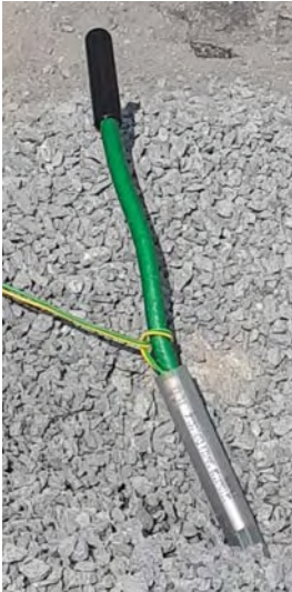
Abb. 26 Befestigung eines Zünders an der Sprengschnur
