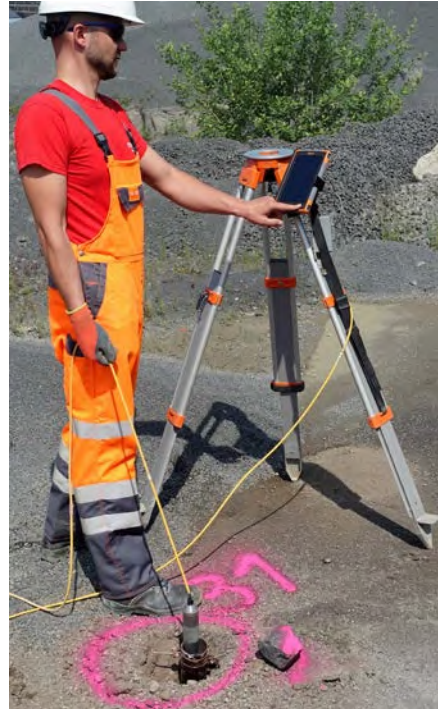
Abb. 31 Messung des Bohrlochverlaufs mit einer Bohrlochsonde
