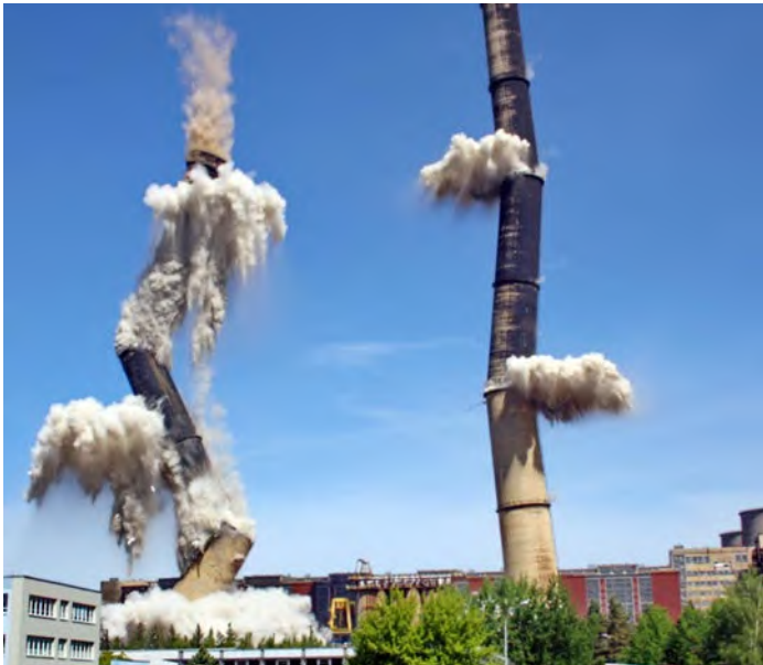
Abb. 41 Bauwerkssprengung
