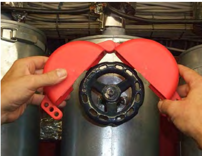
Abb. 9-3 Sicherung der Ventile gegen unbefugtes Öffnen
