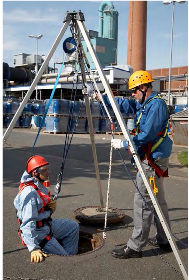
Abb. 9-4 Einstieg in einen Kanal mit erforderlicher Schutzausrüstung
