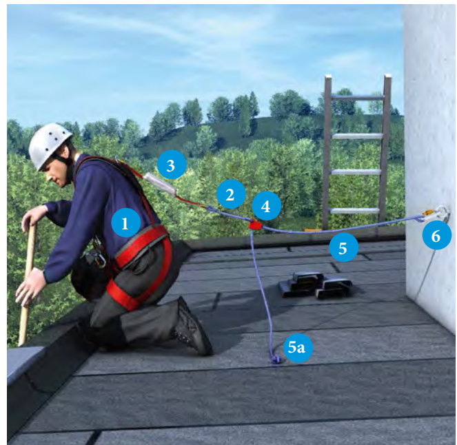
Abb. 4-8 (1) Auffanggurt, (2) Verbindungsmittel, (3) Falldämpfer, (4) mitlaufendes Auffanggerät, (5) bewegliche Führung (z. B. Seil, Band), (5a) Seilensicherung. Die bewegliche Führung (5) muss am mitlaufenden Auffanggerät so eingestellt werden, dass ein Absturz nicht möglich ist. (6) Anschlagpunkt
