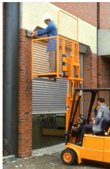
Abb. 4-5 Flurförderzeug mit Arbeitskorb
