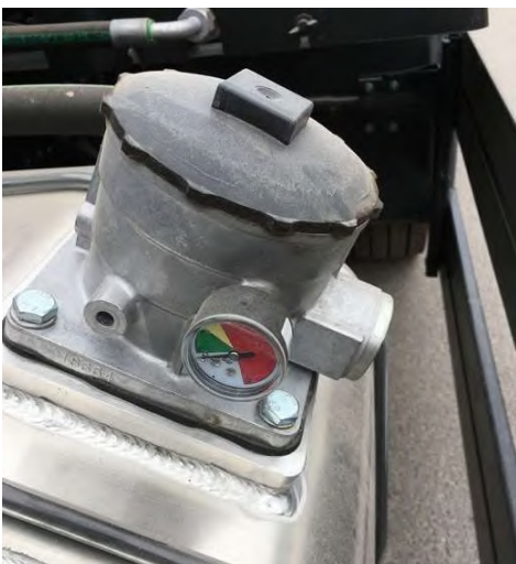
Abb. 9 Filter mit Verschmutzungsanzeige
