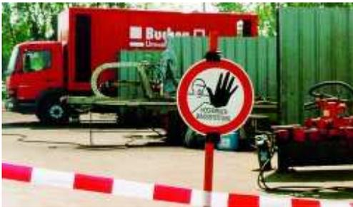
**Abb. 3-10: Da die Gefährdung für Unbeteiligte nicht ohne weiteres ersichtlich ist: Bereich kennzeichnen und absperren.**
