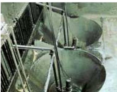
Abb. 5-1: Absetztrichter in Vorklärbecken
