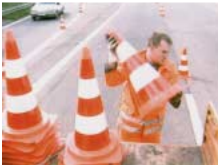
Absperren des Arbeitsbereiches mit Leitkegeln
