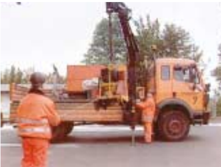
Angeschlagene Lasten von einer gesicherten Position aus führen.
