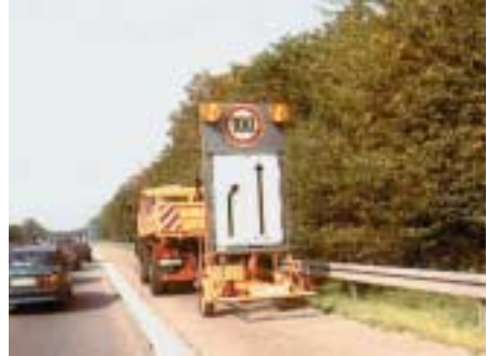
Vorwarntafel als Hinweis auf eine Arbeitsstelle
