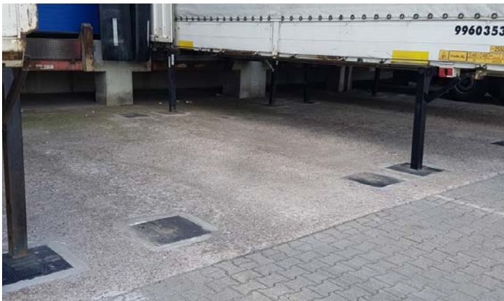
Abb. 3 Beispiel für eine tragfähige und rutschfeste Aufstandsfläche
