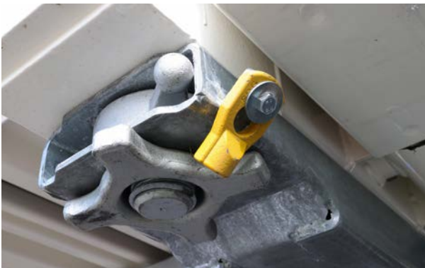
Abb. 28 Spannmutter mit der Fallsicherung gesichert
