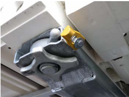
Abb. 14 Stellung der Fallsicherung gegen Rückfall
