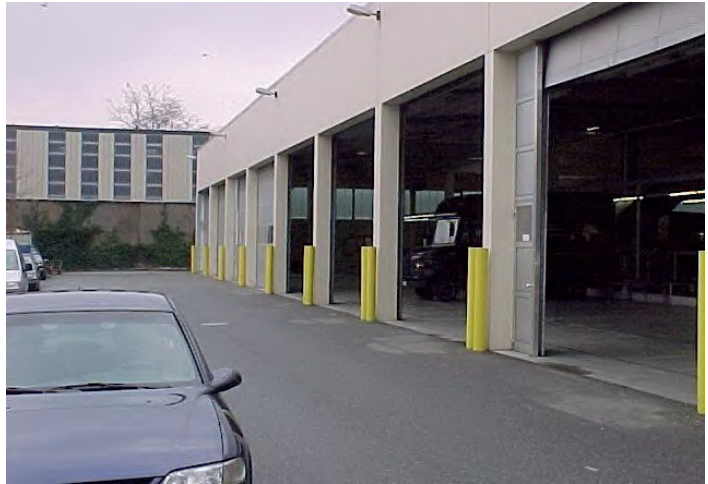
Bild 4 Ladehalle mit mehreren Ein- und Ausfahrttoren
