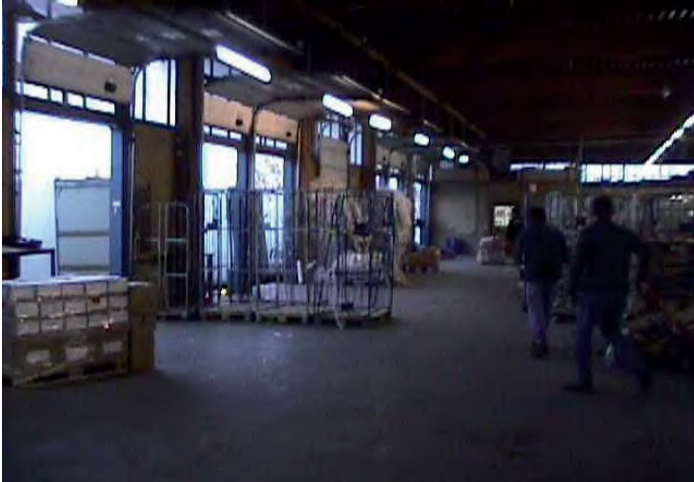
Bild 6 Andocköffnungen, teilweise zu Lüftungszwecken geöffnet
