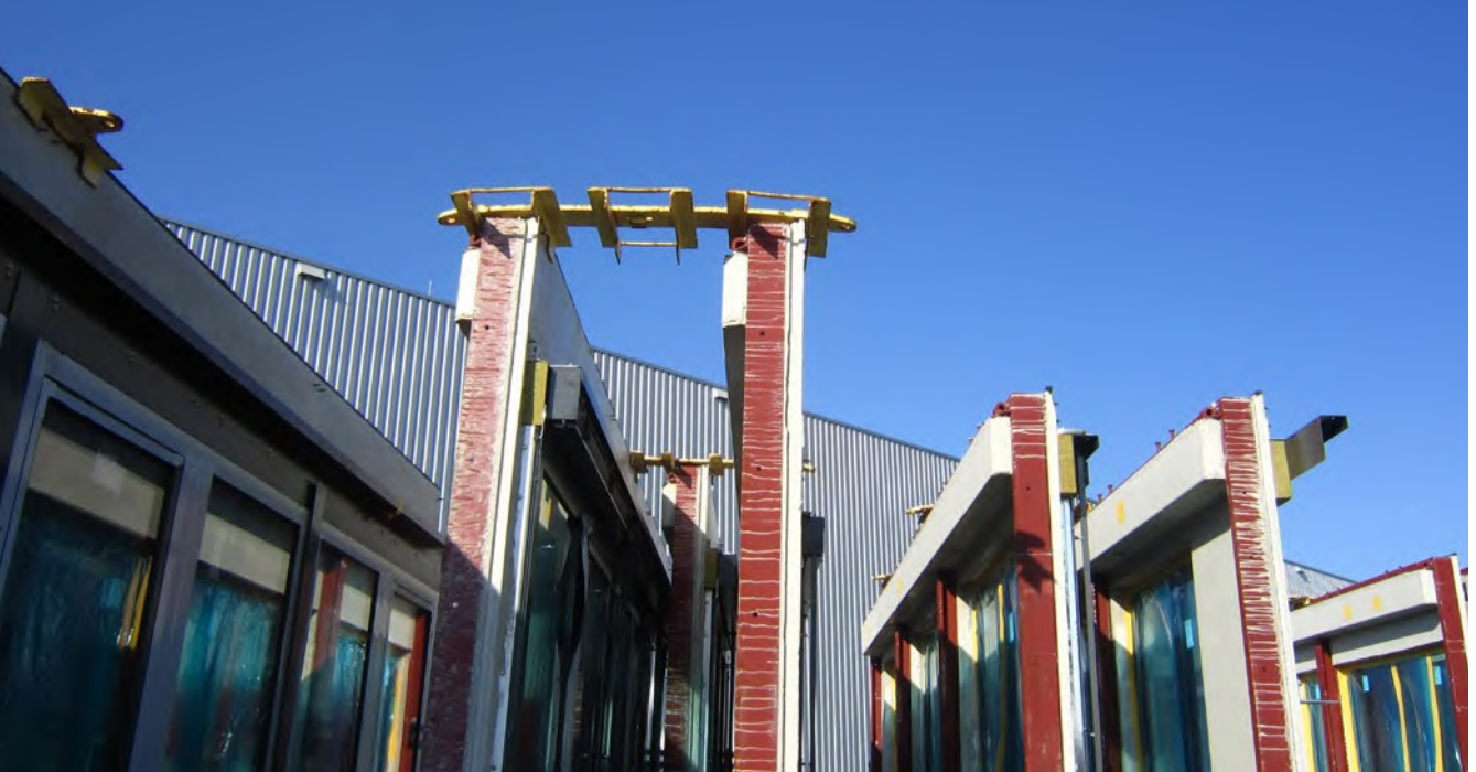
Abb. 22: Beispiel für Abstandhalter an der Oberkante der Betonfertigteile
