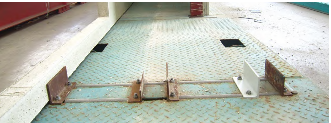
Abb. 23: Beispiel für Abstandhalter im Bodenbereich der IP
