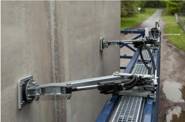
Abb. 4: Seitliches Stützen der Beton-Fertigteile durch Verspanneinrichtungen am Fahrzeug
