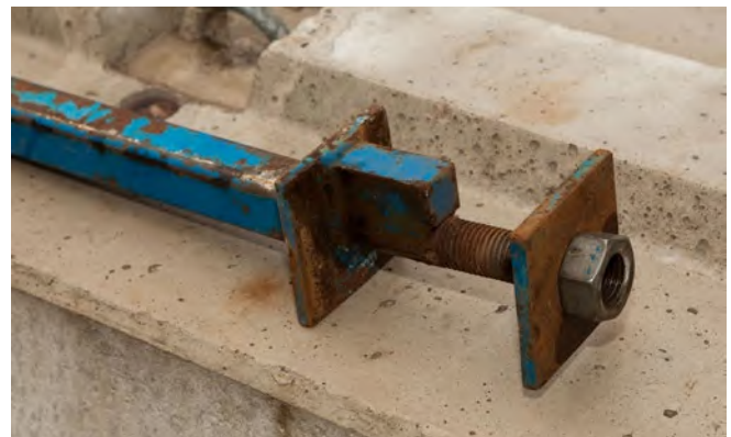
Abb. 20: Schraubarretierung mit zusätzlicher Verdrehsicherung
