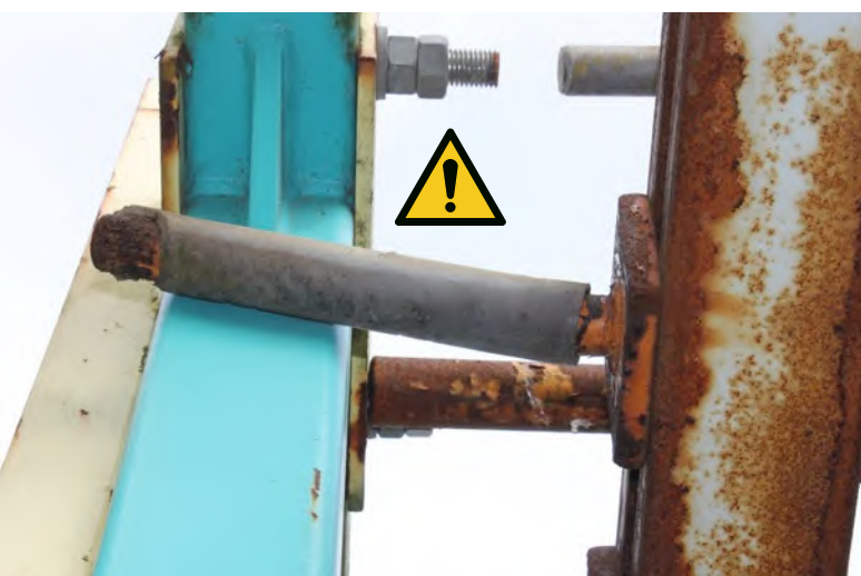
Abb. 13: Beschädigtes Arretierungselement einer IP
