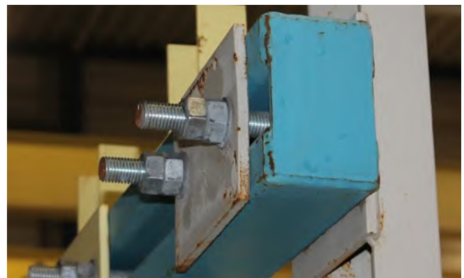
Abb. 21: Arretierungselement durch Kontermutter gesichert
