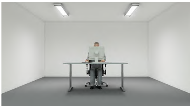
Abb. 16 Beispiel für Direktbeleuchtung
