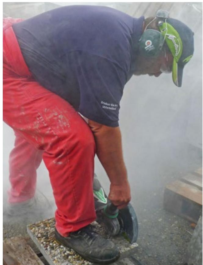
Abb. 18 Trennen von Betonplatten und Winkelschleifer
