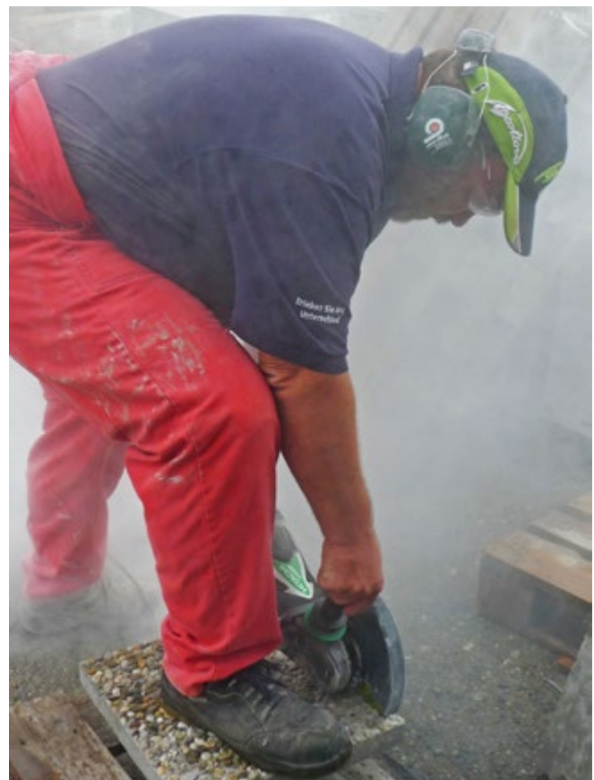
Abb. 18 Trennen von Betonplatten und Winkelschleifer
