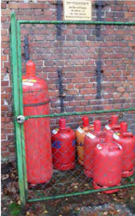
Abb. 8-2 Lagerung gefüllter Druckgasbehälter im Freien
