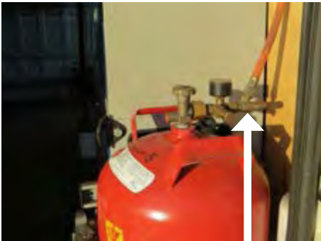
Abb. 6-3 Schlauchbruchsicherung
