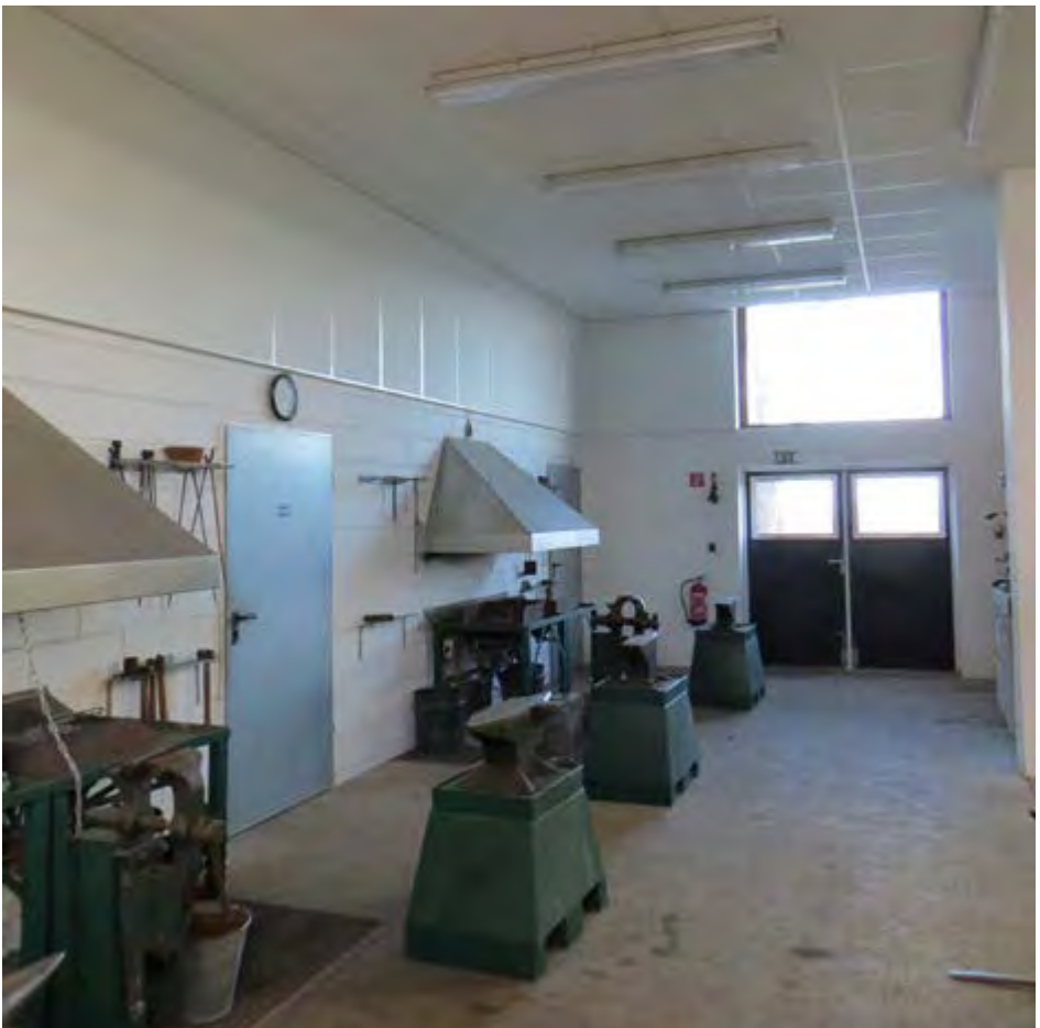
Abb. 3-3 Lärmgeminderte Decke in einer Schmiedewerkstatt
