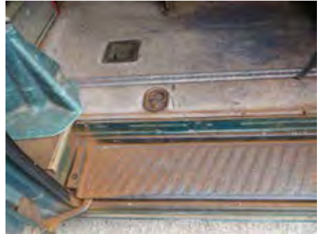
Abb. 9-2 Belüftungsöffnung im Fahrzeugboden
