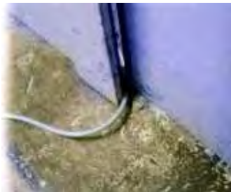
eingeklemmte Leitung
