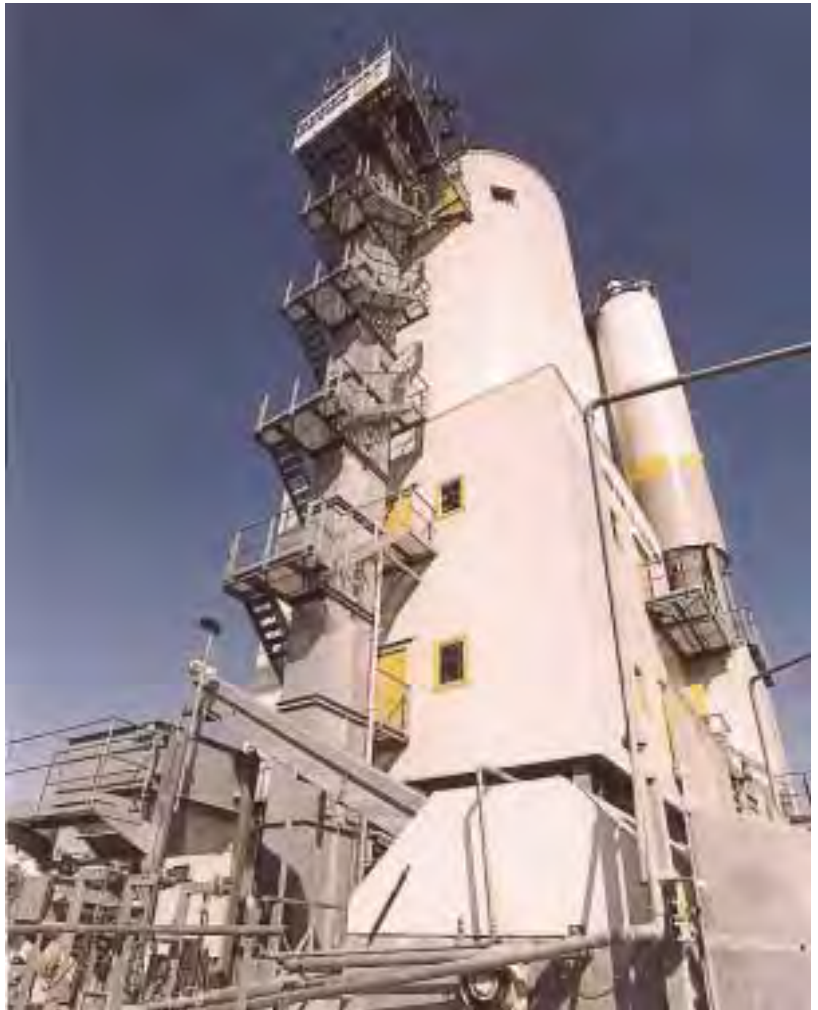
Abb. 37: Treppenaufgang um das Becherwerksgehäuse
