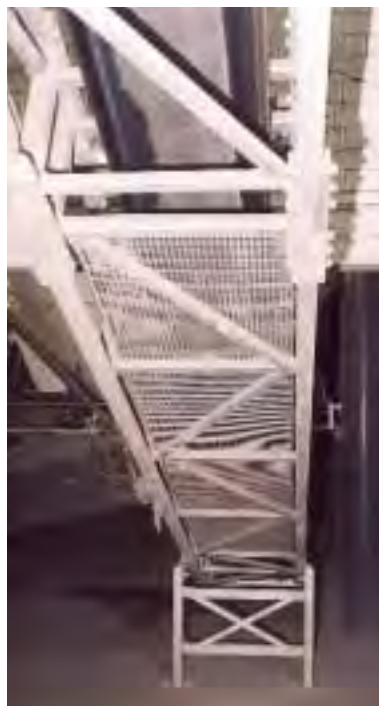
Abb. 21: Vollständige Verkleidung über einem Verkehrsweg
