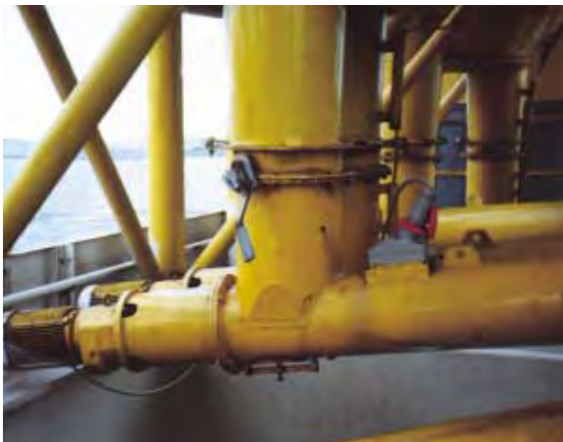
Abb. 41: Allpolige Trennung durch Steckvorrichtung
