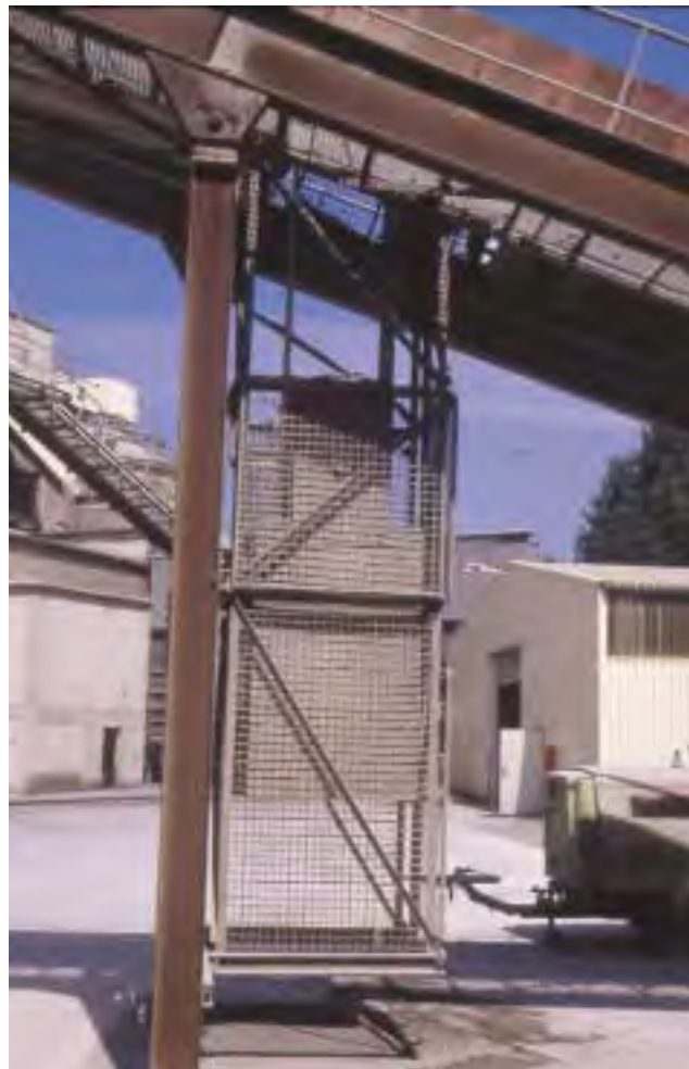
Abb. 17: Verdeckung einer Spannstation
