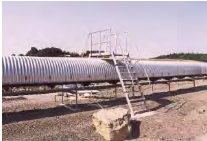
Abb. 47: Sicher zu überqueren durch den Laufsteg
