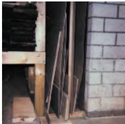
Lagerung von Platten (gegen Wegrutschen gesichert)
