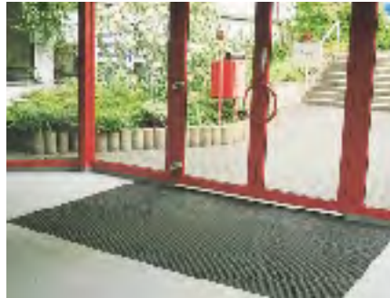
Schmutzfang im Eingangsbereich bodeneben (maximal 4 mm Kante)
