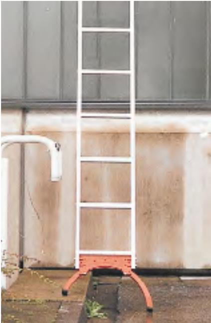
*Bild 9: Verstellbarer Leiterfuß zum Ausgleich von Bodenunebenheiten*
