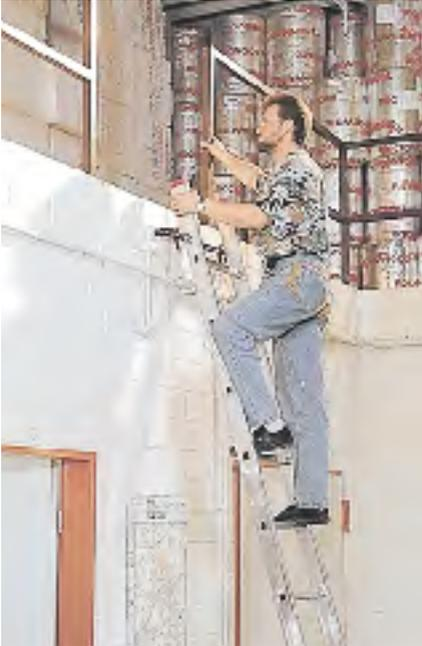
*Bild 12: Beim Übersteigen auf einen höher gelegenen Arbeitsplatz muss eine Haltemöglichkeit vorhanden sein*
