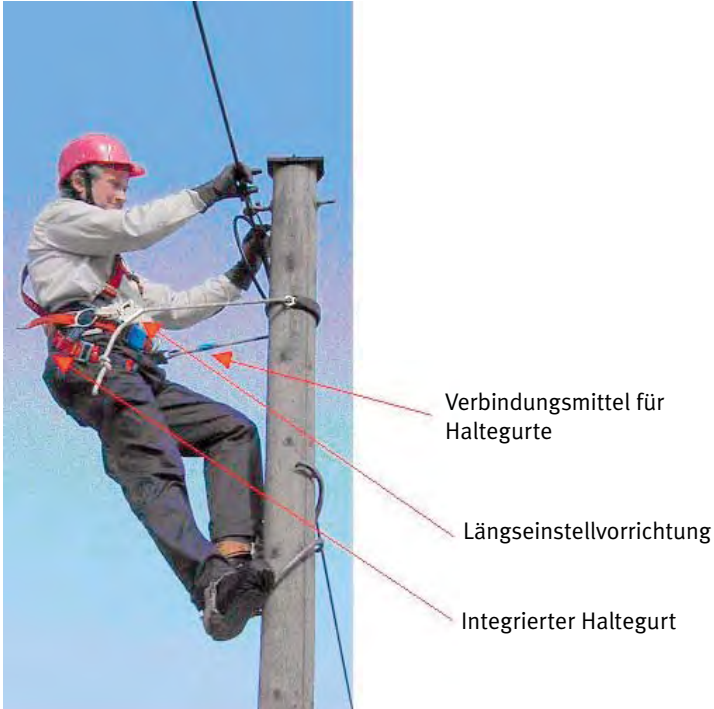
Bild 4: Arbeitsplatzpositionierung an einem Mast durch einen Auffanggurt mit integrierter Haltefunktion
