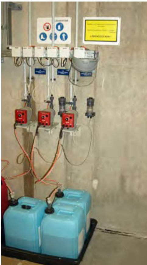
Abb. 8 Natriumhypochlorit-Einrichtung
