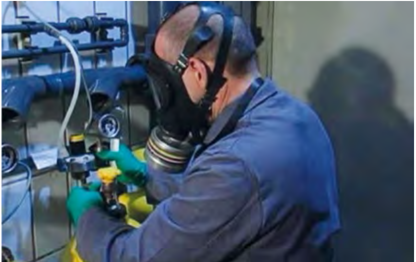
Abb. 9 Chlorgasbehälterwechsel unter Atemschutz
