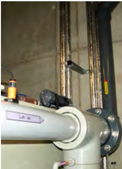
Abb. 5 Luftzufuhr und Wasserstoffableitung
