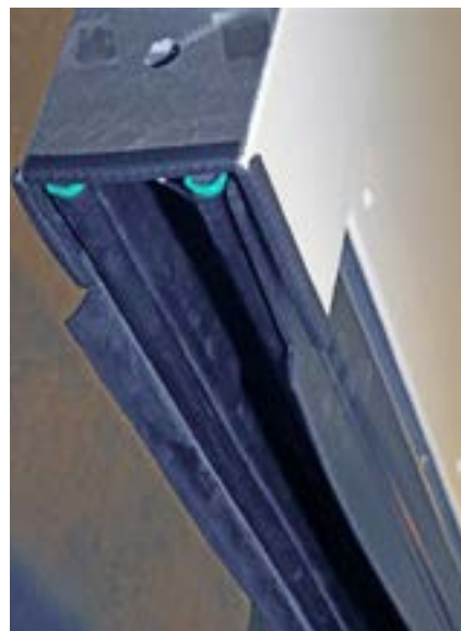
Abb. 8 Hauptschließkante am Tor mit zwei Schaltleisten
