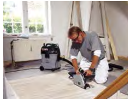
Abb. 5 Entstaubung beim Sägen
