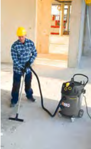
Abb. 1 Baustellenreinigung mit Staubsauger
