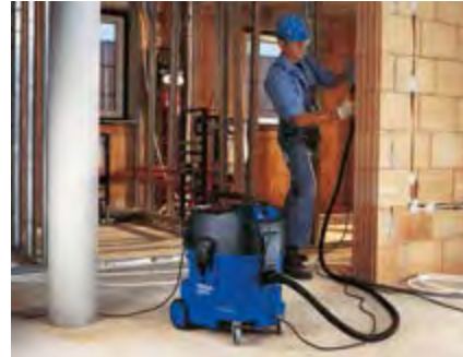
Abb. 4 Entstauber im Baustelleneinsatz
