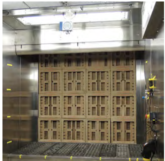
Abb. 7: Trockenfilterwand vollständig montiert
