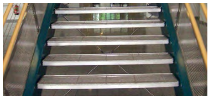
Abb. 2 Treppe ohne Setzstufe
