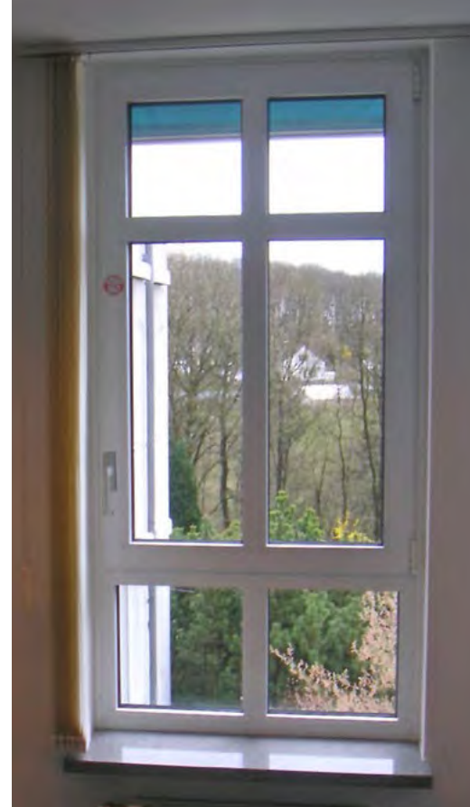
Abb. 1 Fenster mit Unterlicht
