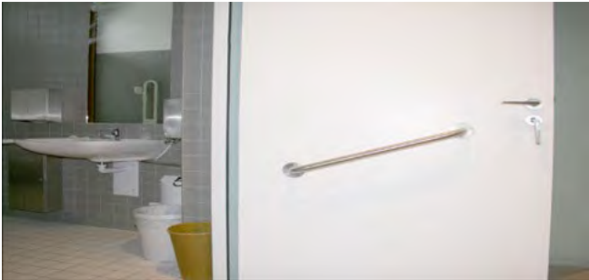
Abb. 5 Griffstange an der „Zuziehseite“ der Tür
