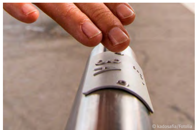
Abb. 11 Taktiler Information am Handlauf sowohl über Braille- als auch über Reliefschrift
