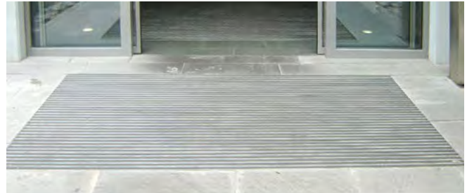
Abb. 3 Stufen- und Schwellenfreier Eingang
