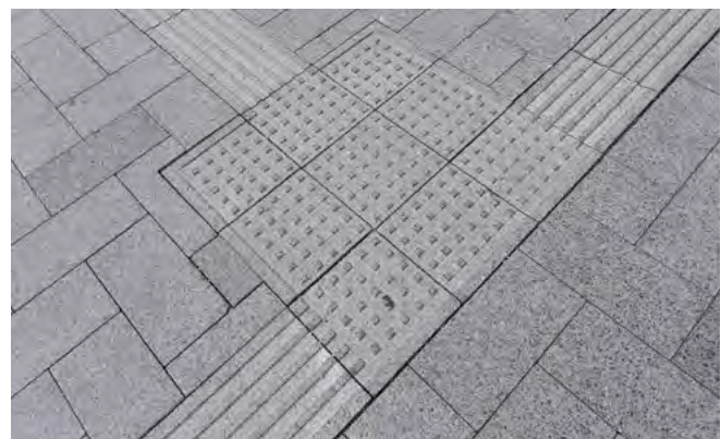
Abb. 10 Rippenstruktur zur Längsorientierung, Abzweigungsfeld in Noppenstruktur
