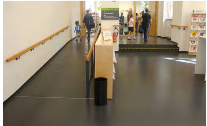
Abb. 6 Treppe und Rampe als Alternative für alle
