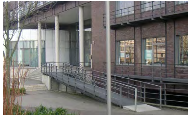
Abb. 4 Rampe im Außenbereich mit Gitterrostbelag
