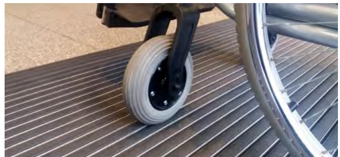
Abb. 4 Vermeidung von Schlitten und Öffnungen im Bodenbelag
