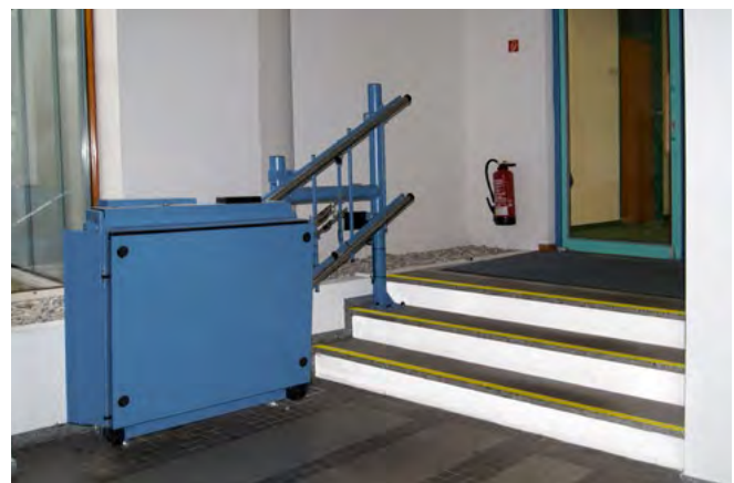
Abb. 12 Plattform-/Schrägaufzug
