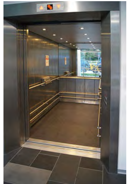
Abb. 9 Spiegel in Aufzugskabine
