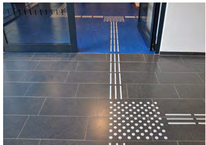
Abb. 9 Bodenindikatoren am Beispiel aufgeklebter Rippen und Noppen
