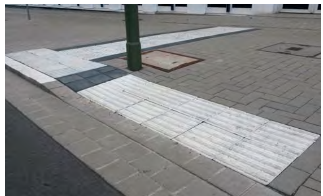
Abb. 6 Visuell und taktile kontrastreiche Bodenbeläge
