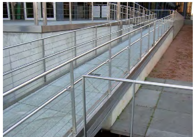
Abb. 7 Rampe im Außenbereich mit Betonplattenbelag
