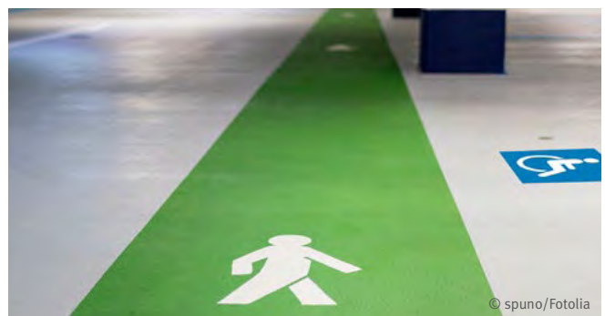
Abb. 5 Fußboden taktil und visuell kontrastreich
