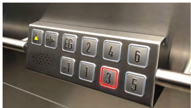
Abb. 8 Anordnung von Handlauf und Bedienelementen in Aufzugskabine
