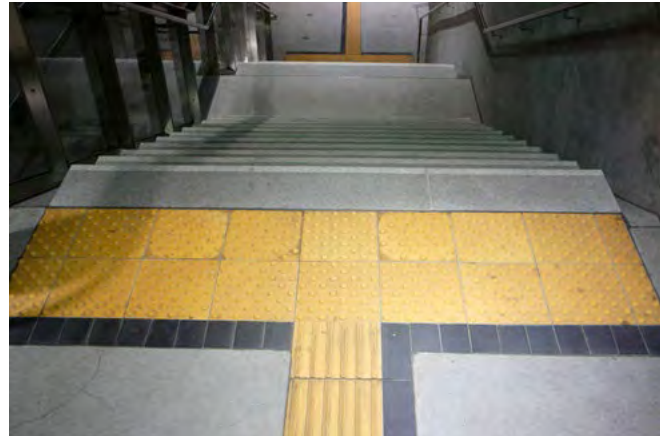
Abb. 11 Hinweis auf Gefahrenstelle
