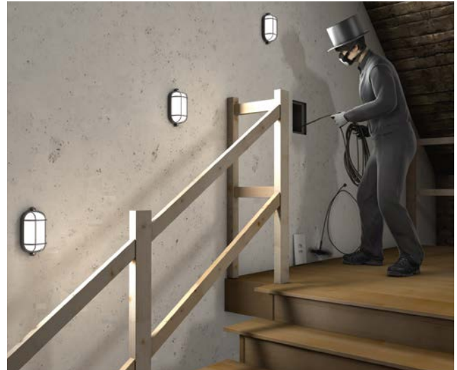
Abb. 15 Arbeitsplatz unter Dach mit Absturzsicherung
