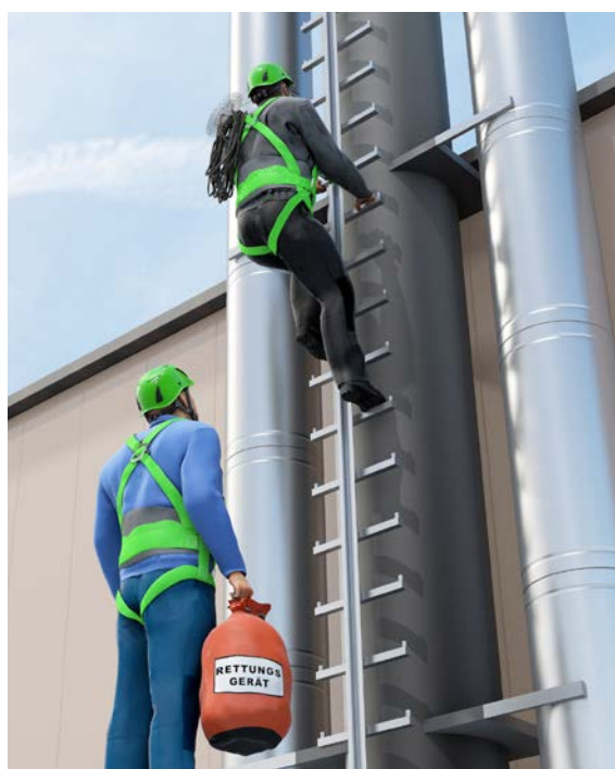
Abb. 26 Beispiel für eine Steigschutzeinrichtung
