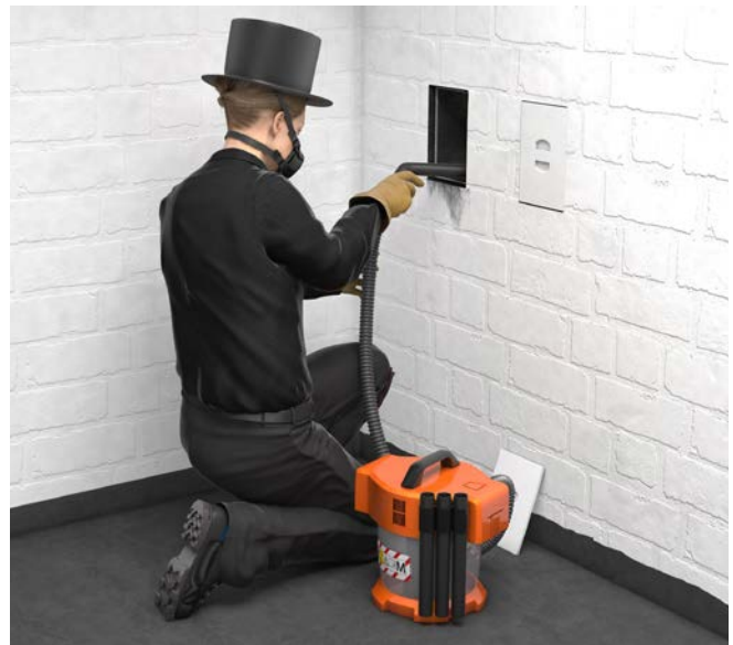
Abb. 22 Einsatz eines Entstaubers
