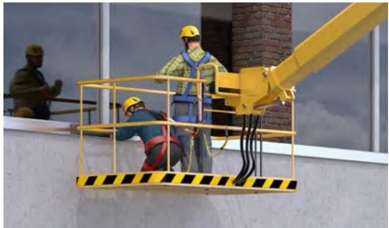
Abb. 64 Auffanggurt mit vorderer/hinterer Auffangöse und längenverstellbares (max. 1,80 m) Verbindungsmittel mit Falldämpfer
