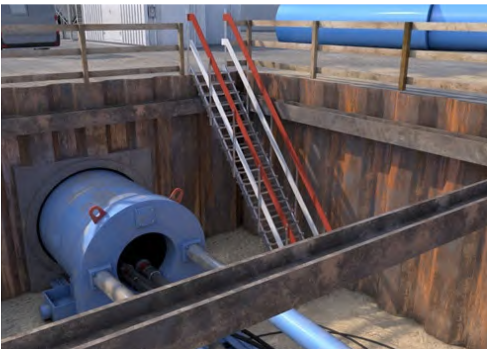
Abb. 137 Unbemannte Rohrvortriebsarbeiten, Baugrube mit Treppenzugang
