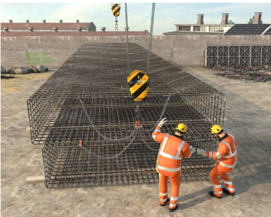
Abb. 134 Anschlagen eines Bewehrungskorbes
