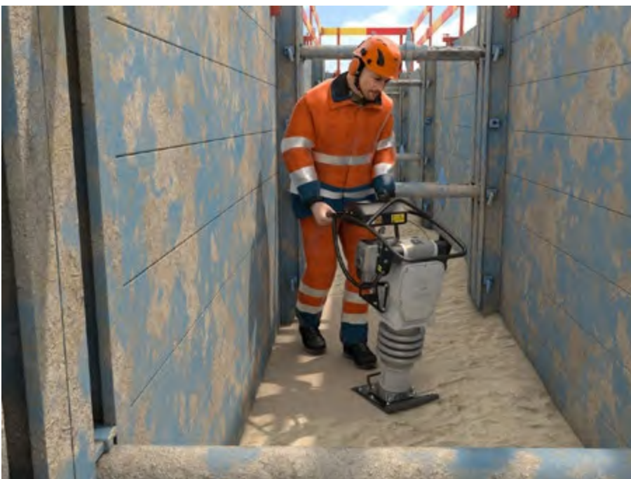
Abb. 94 Verdichtungsarbeiten mit einem Akku betriebenen Stampfer
