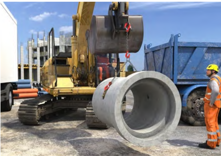
Abb. 59 Transport einer formschlüssig angeschlagenen Last
