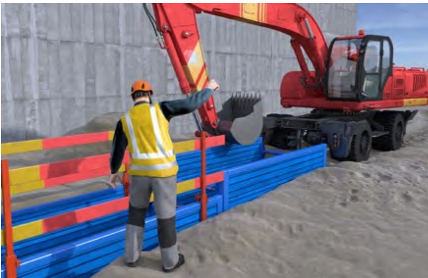
Abb. 113 Absturzsicherung am Verbau
