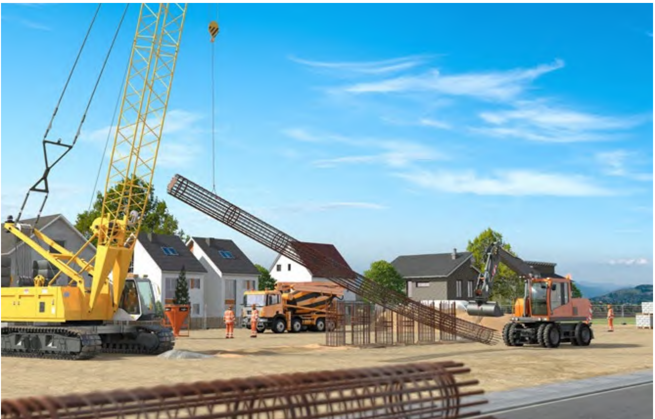
Abb. 128 Heben eines Bewehrungskorbes
