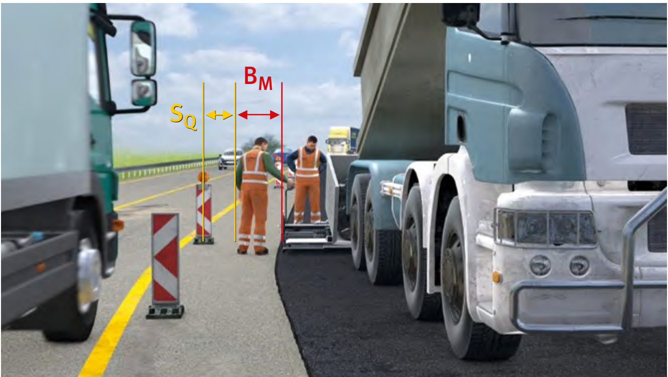
Abb. 101 Erforderlicher Arbeitsraum ( B_M ) und Sicherheitsabstand ( S_Q )
