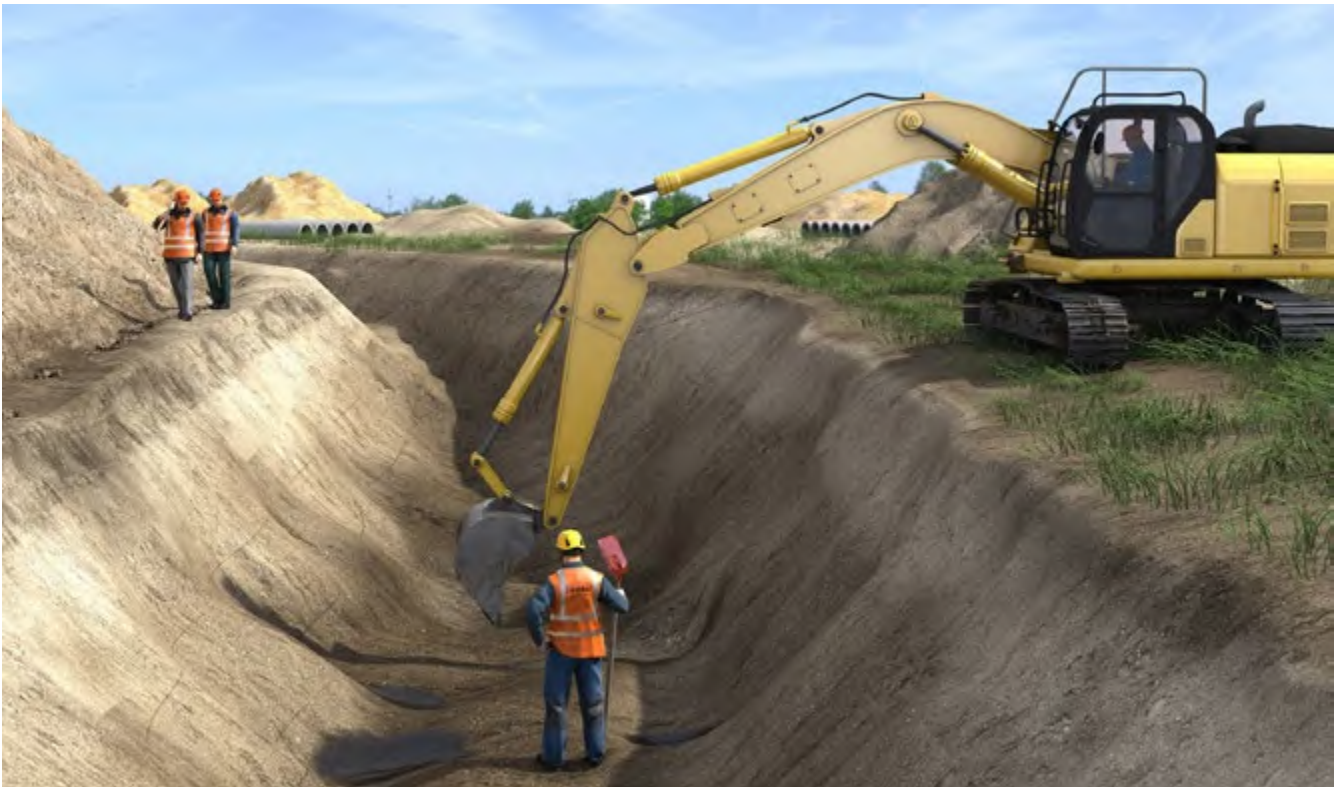
Abb. 105 Schutzstreifen am Baugruben/Grabenrand
