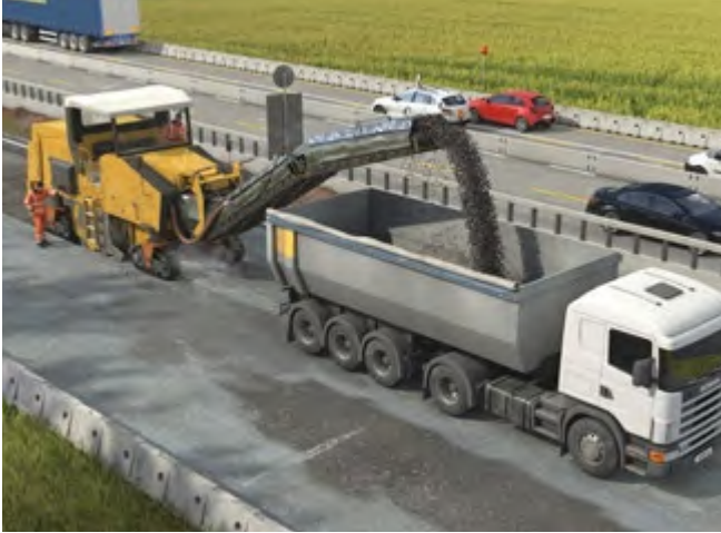
Abb. 103 Großfräse mit Absaugung
