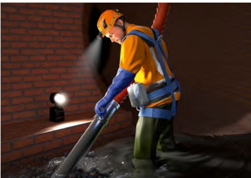
Abb. 16 Beispiel für Schutzkleidung und PSA bei Arbeiten in Abwassertechnischen Anlagen
