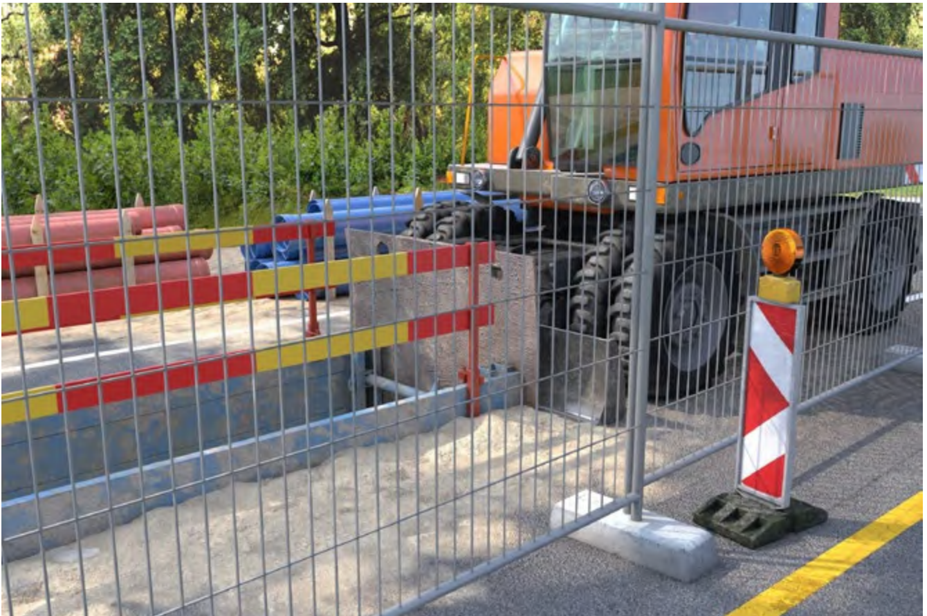
Abb. 110 Sicherung der Stirnseite des Verbaus
