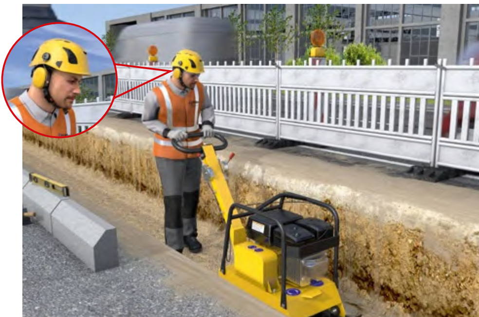
Abb. 55 Verdichtungsarbeiten mit geeignetem Gehörschutz
