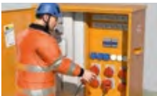
Abb. 28 Verschließbarer Baustromverteiler mit 30 mA und 500 mA Fehlerstrom-Schutzeinrichtungen
