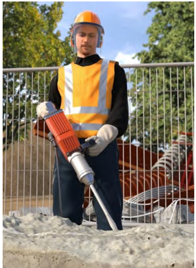
Abb. 45 Persönliche Schutzausrüstungen bei Arbeiten mit dem Stemmhammer
