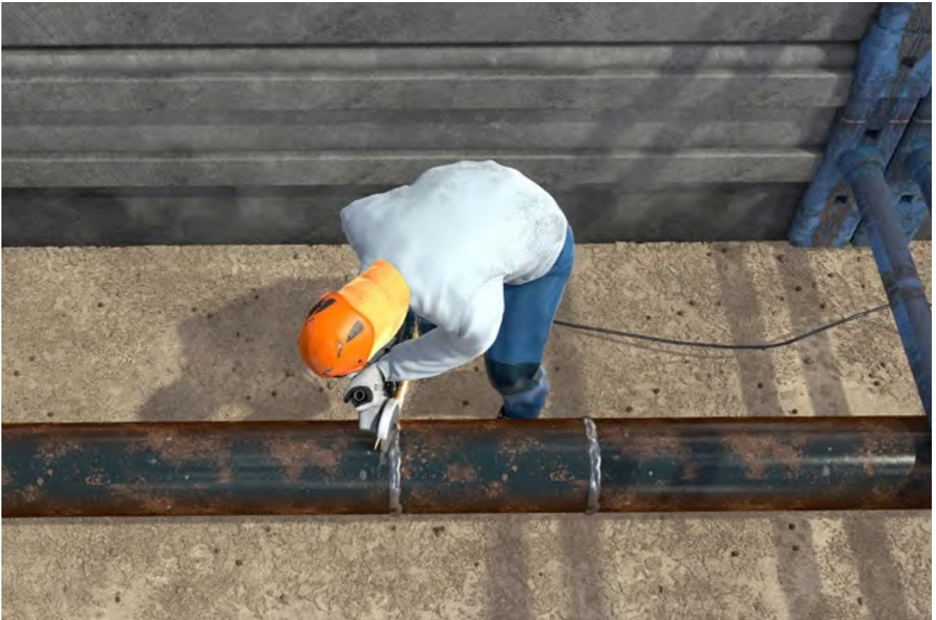
Abb. 41 Persönliche Schutzausrüstungen bei Arbeiten mit dem Winkelschleifer
