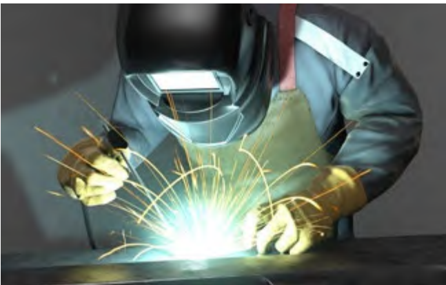
Abb. 65 Schweißen nur mit Schutzausrüstungen
