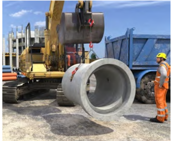
Abb. 87 Transport einer formschlüssig angeschlagenen Last
