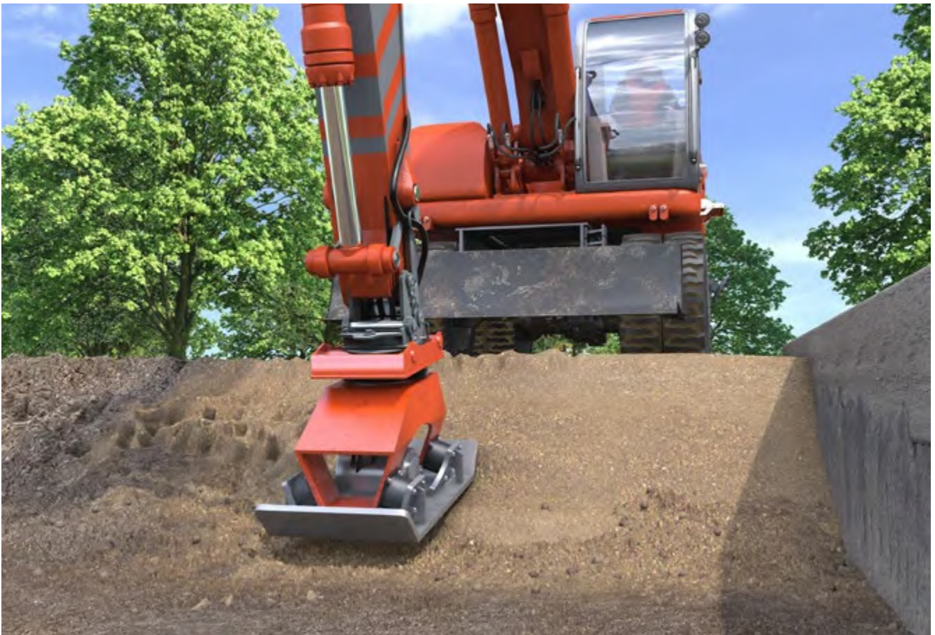
Abb. 46 Reduzierung von körperlichen Belastungen bei Verdichtungsarbeiten durch Einsatz von Anbauverdichtern
