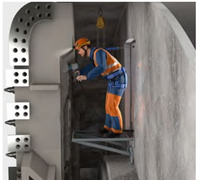
Abb. 143 Arbeitsbühne und PSA beim Werkzeugwechsel
