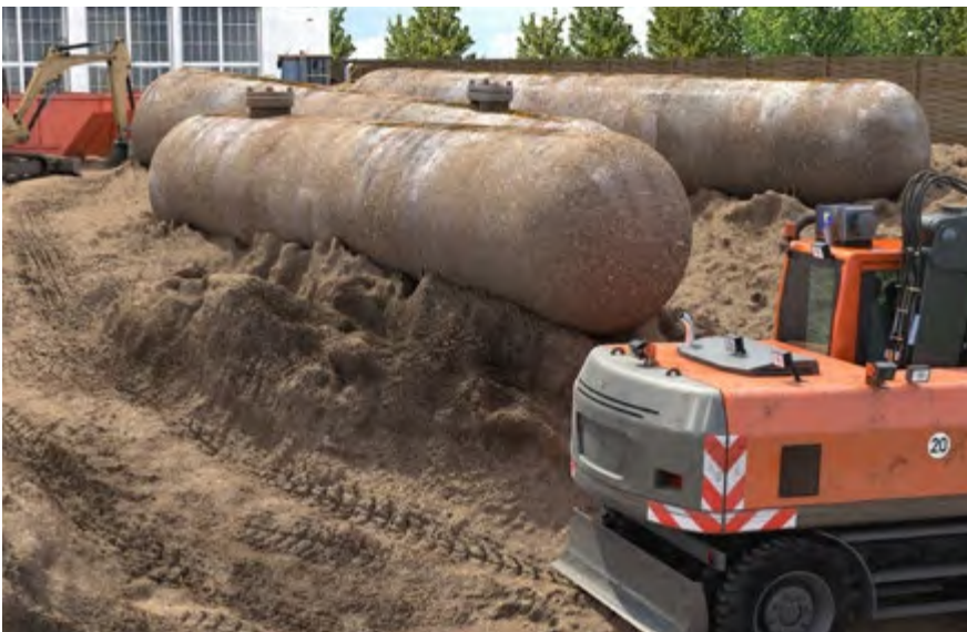
Abb. 17 Erdarbeiten in kontaminierten Bereichen
