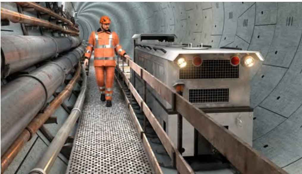
Abb. 138 Trennung von Fahr- und Fußweg
