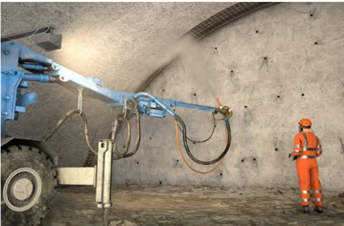
Abb. 140 Einsatz von Naßspritzbeton und Manipulator
