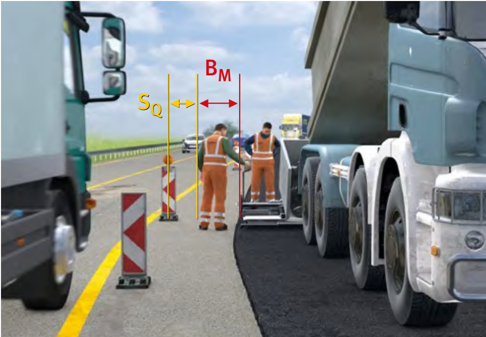
Abb. 9 Absicherung durch Leitbaken
