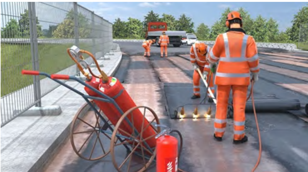
Abb. 35 Arbeiten mit Handbrennern
