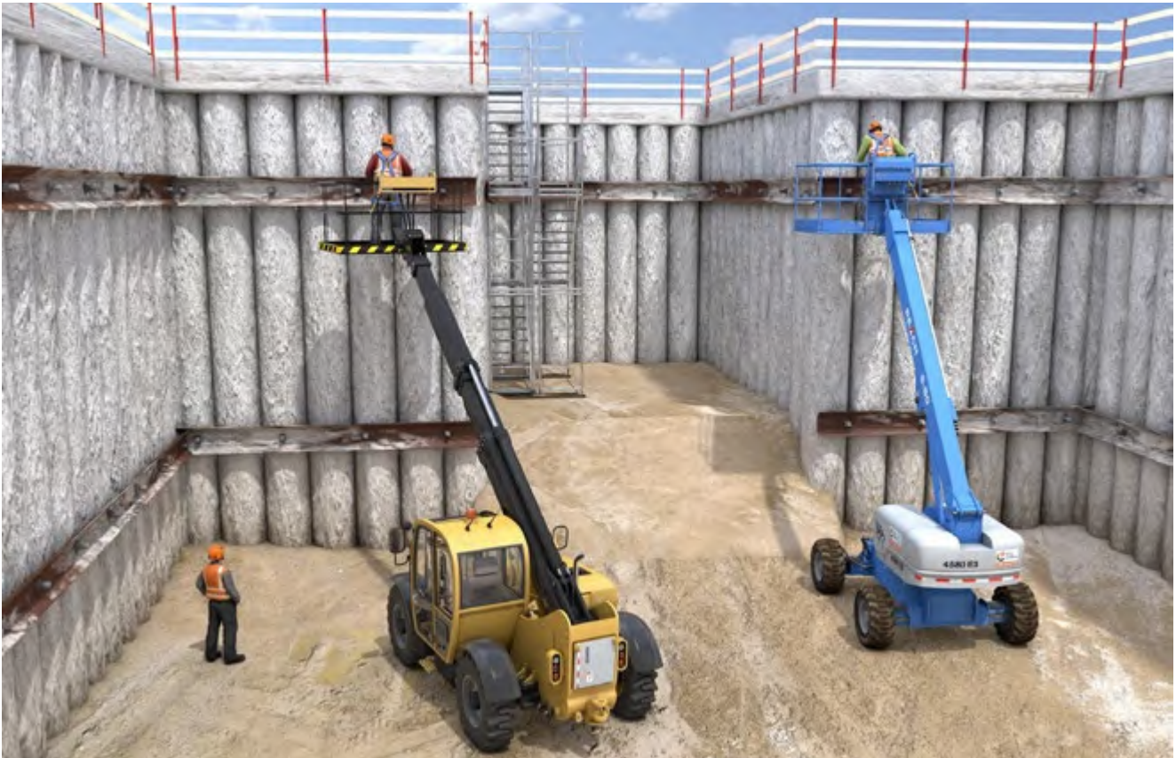
Abb. 88 Hubarbeitsbühne und Teleskopstapler für das Heben von Personen
