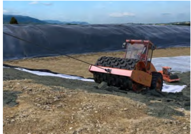
Abb. 78 Einsatz auf Böschungen
