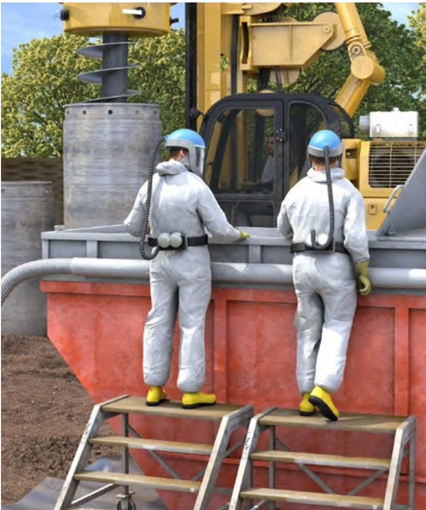
Abb. 19 Persönliche Schutzausrüstungen bei Arbeiten in kontaminierten Bereichen
