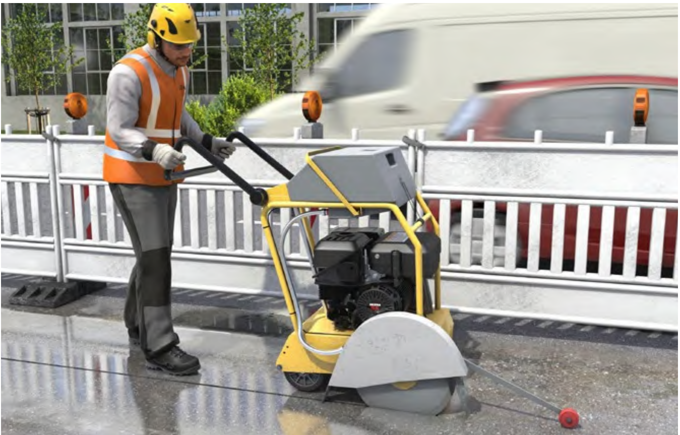
Abb. 13 Staubminimierung durch Nassschneiden
