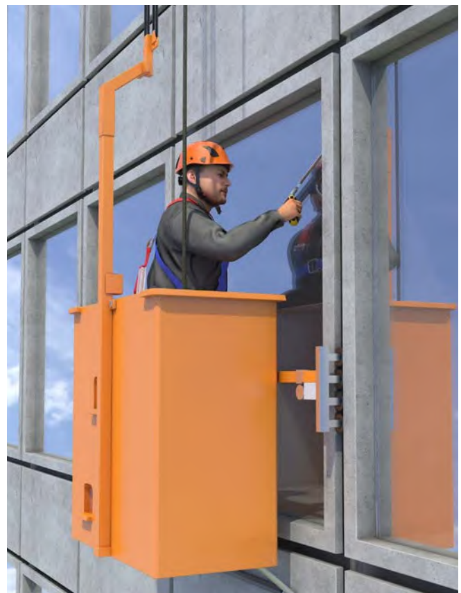
Abb. 62 Fassadenreinigung mit Fassadenbefahranlage
