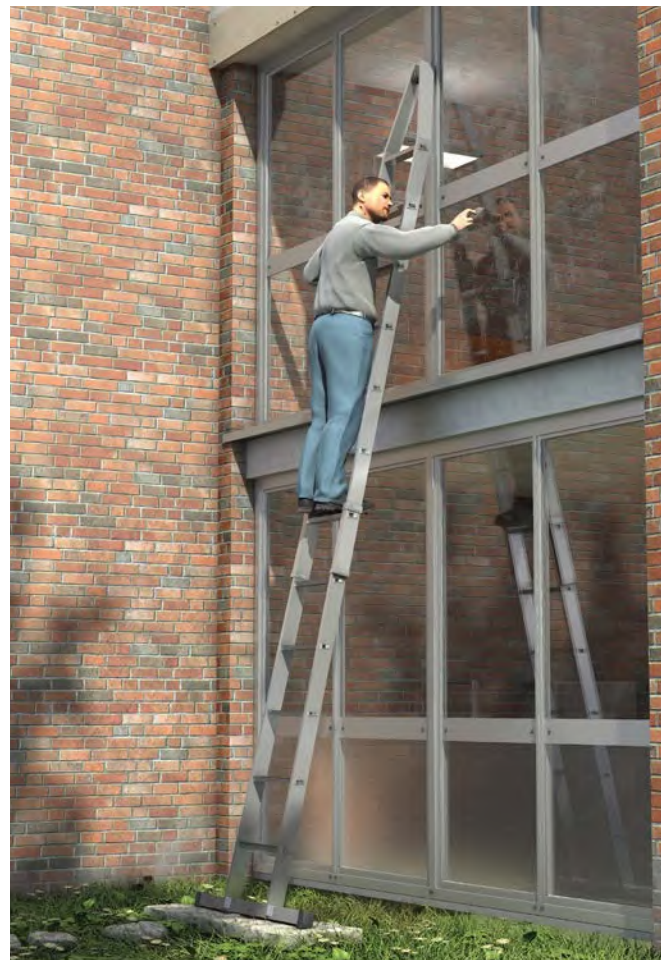
Abb. 46 Glasreinigerleiter mit Fußverbreiterung auf tragfähigen Untergrund
