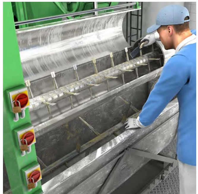
Abb. 73 Anlage gegen Einschalten gesichert
