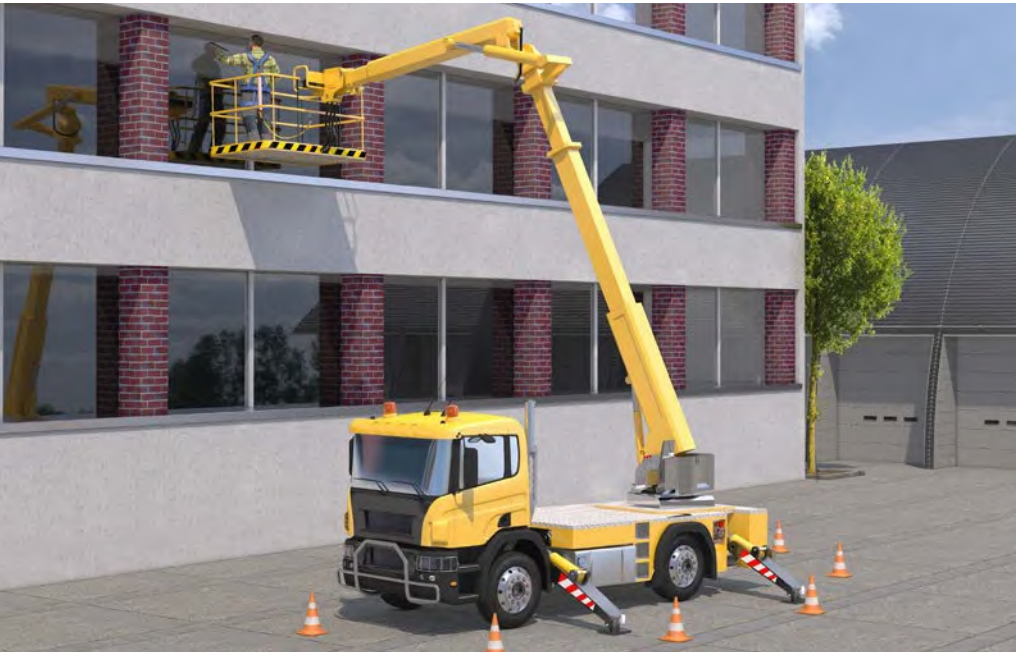
Abb. 41 Teleskopbühne im Einsatz
