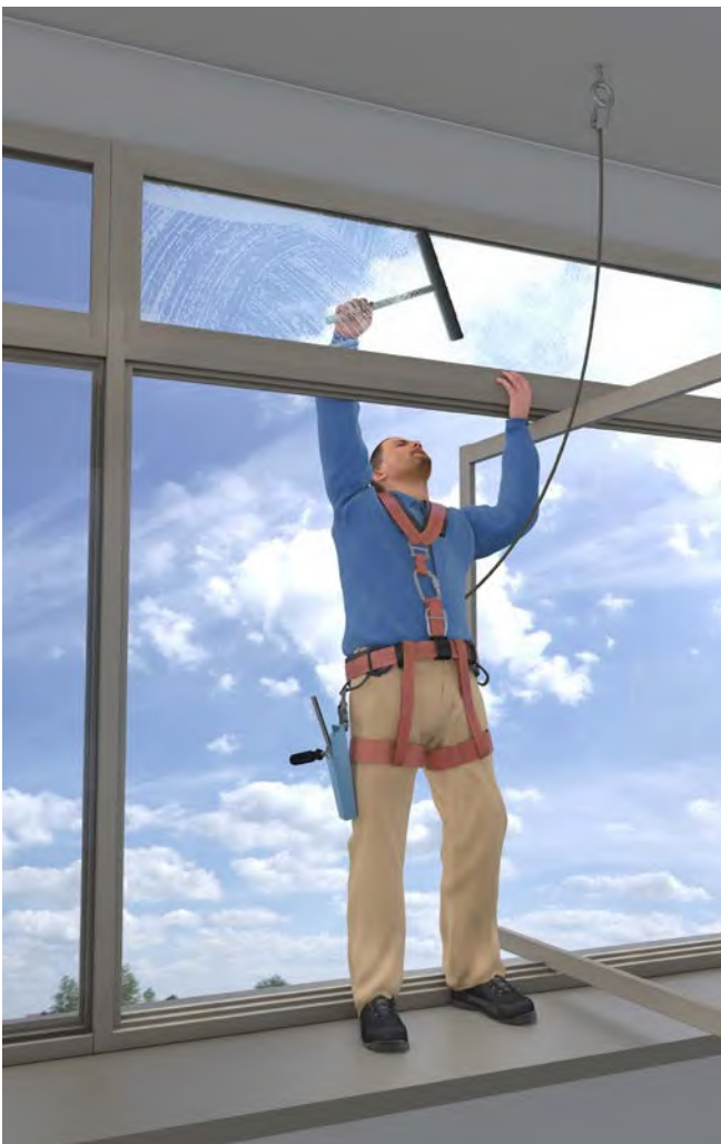
Abb. 1 Einsatz von PSAgA bei Fensterreinigung
