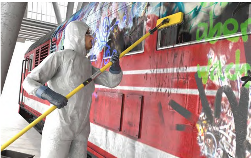
Abb. 78 Graffiti-Entfernung auf dem Betriebshof
