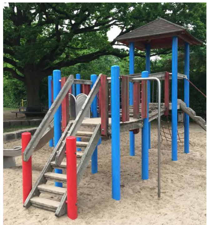
Abb. 31 Bei Klettergeräten ist ein entsprechender Untergrund erforderlich.
