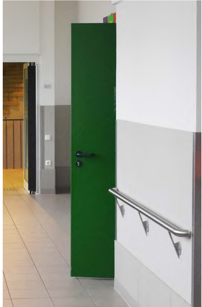
Abb. 6 Türen müssen so eingebaut und angeordnet sein, dass Vorbeilaufende durch nach außen aufschlagende Türflügel nicht gefährdet werden.
