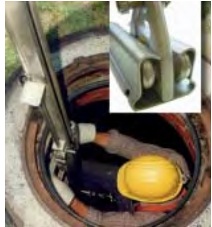
Bild 9: Steigleiter mit Mittelholm, Steigschutzeinrichtung und steckbarer Haltevorrichtung
