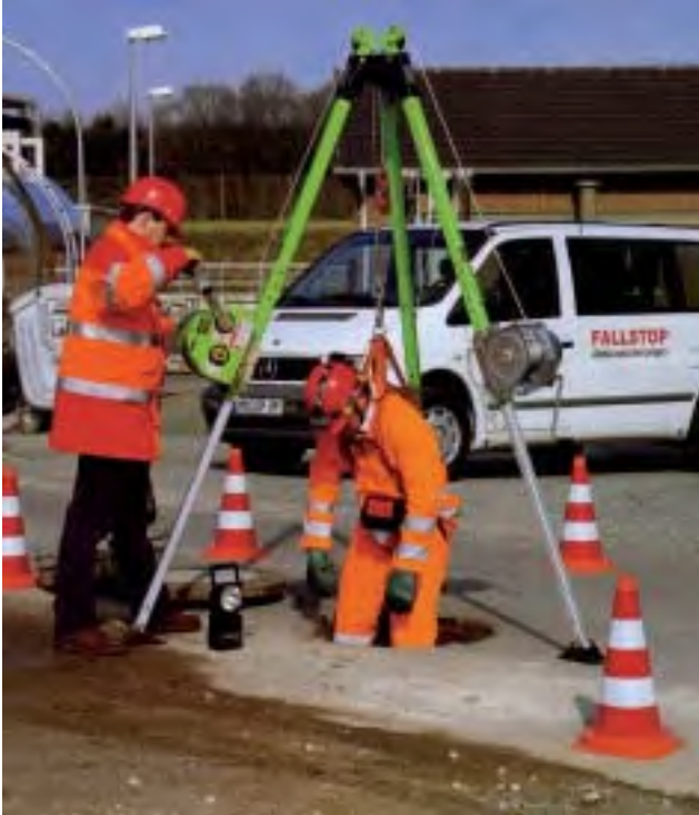
Bild 18: Rettung aus einem Schacht
