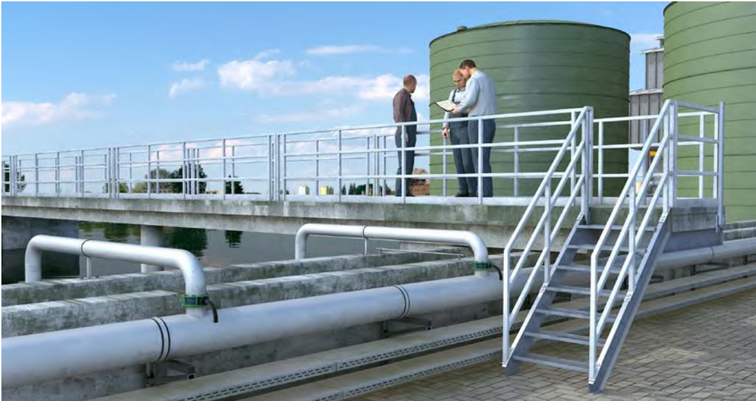
Abb. 8 Geländer sichern Beschäftigte an Treppen und Beckenrändern.
