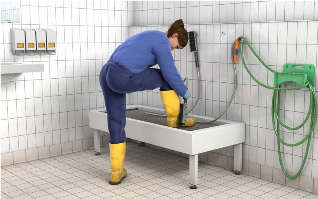
Abb. 4 Die Stiefelwaschanlage sorgt dafür, dass Beschäftigte den Schmutz nicht in die betrieblichen Räume tragen.
