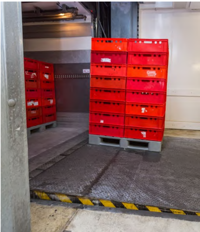
Abb. 63 Ladebrücken/-bleche müssen rutschhemmend und ausreichend breit sowie mit einer selbsttätig wirkenden Sicherung gegen Verschieben ausgerüstet sein.
