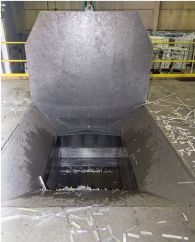
Abb. 58 Blick in die Presse bei geöffnetem Deckel, großräumige Absperrung durch Geländer im Hintergrund sichtbar
