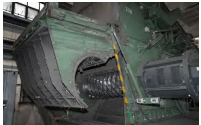
Abb. 64 Mechanische Sicherung des geöffneten Mühlendeckels (gelb-schwarze Stange)
