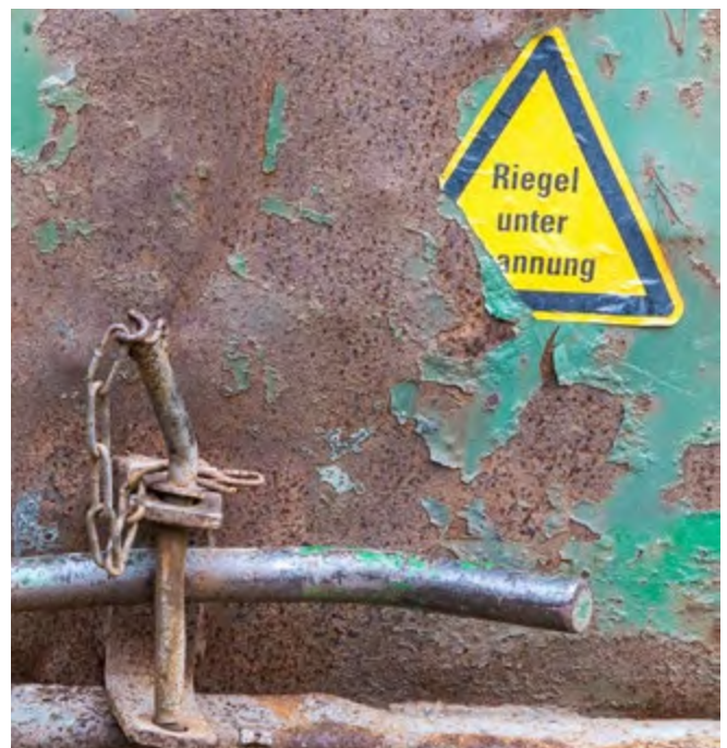
Abb. 10 Schild weist auf möglichen Öffnungsdruck hin
