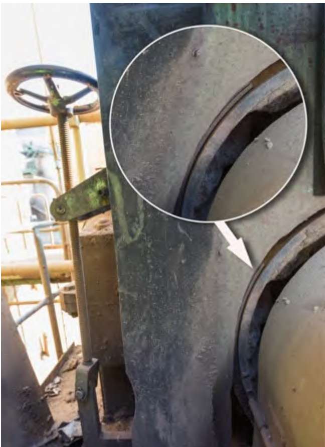
Abb. 62 Bremse an der Welle des Hammerbrechers
