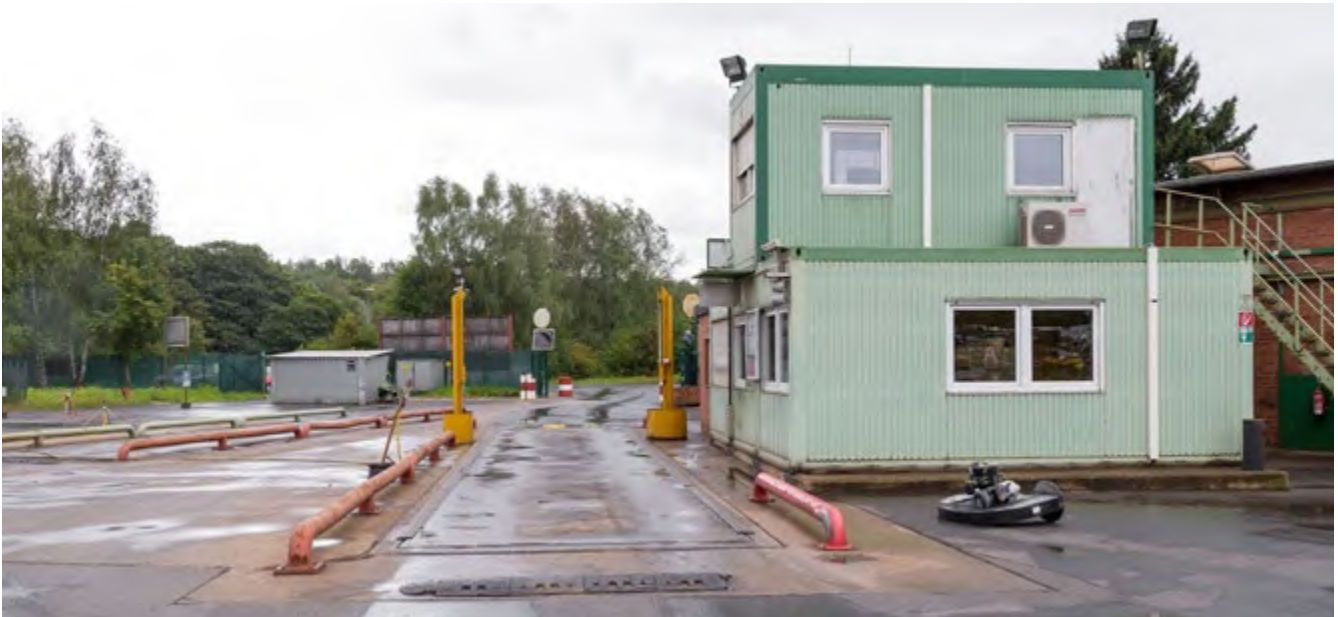
Abb. 21 Klar gegliederter Zufahrtsbereich mit Fahrzeugwaage und Detektoren zur Erkennung radioaktiver Strahlenquellen
