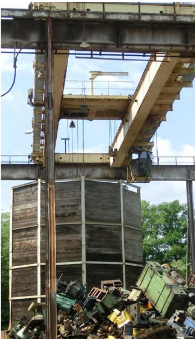
Abb. 48 Intakte Schutzwand eines Fallwerkes
