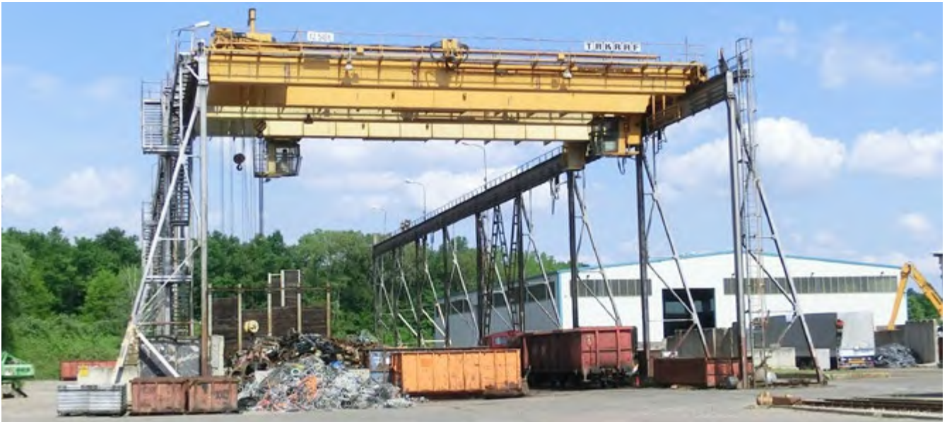
Abb. 39 Brückenkrane für Schrottschlag
