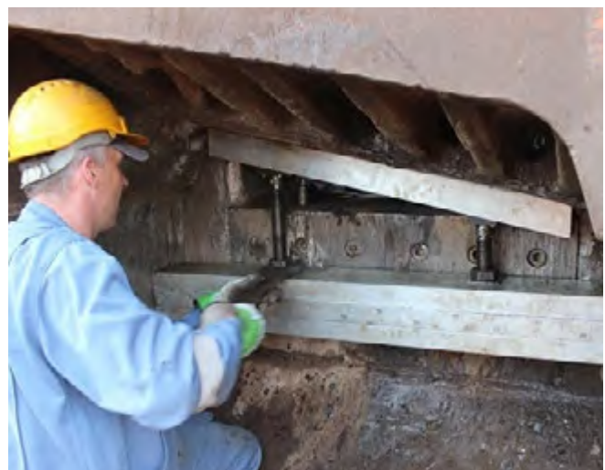
Abb. 78 Positionierung der Messersegmente
