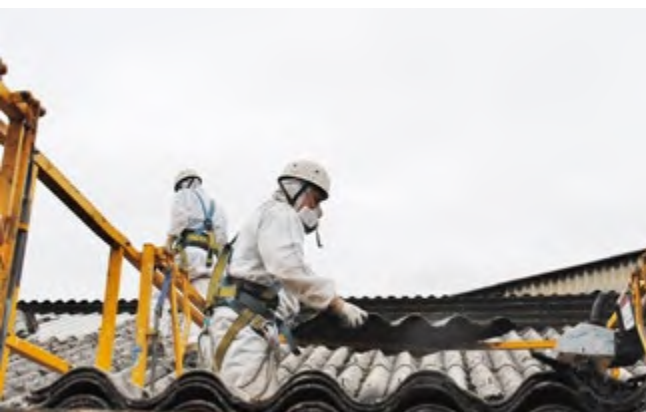
Abb. 108 Handabbruch von Wellasbestzementplatten
