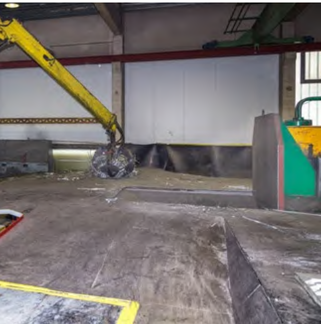
Abb. 60 Gute Sicht auf die Gefahrstellen am Pressenschacht
