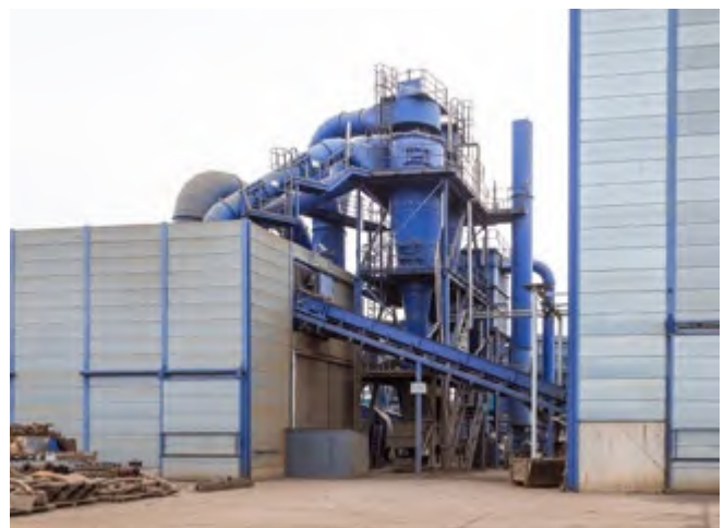
Abb. 66 Einhausung mit schallabsorbierendem Material als Lärmschutz
