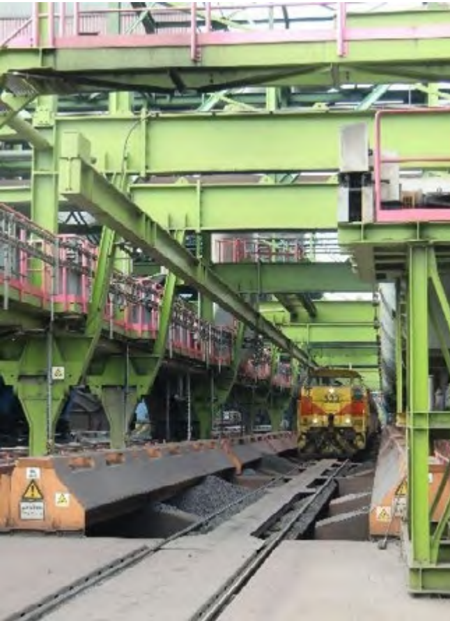
Bild 16 Bunkeranlage für Erz und Zuschlagsstoffe
