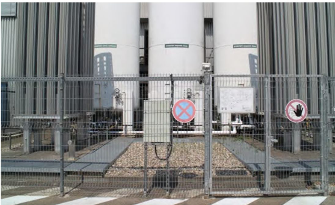
Abb. 30 Stickstofftanks mit Verdampfern
