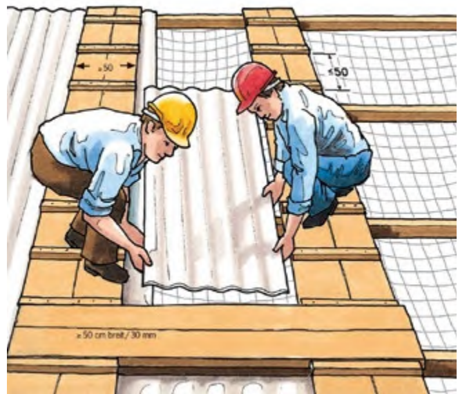
Abb. 3.5.2-04 Dachdeckung mit Wellplatten
