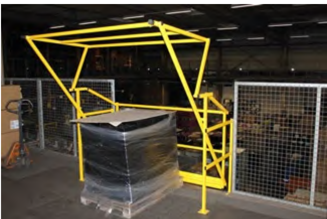
Abb. 3.4.3-05 Sicherheitschleuse für Lagerbühne
