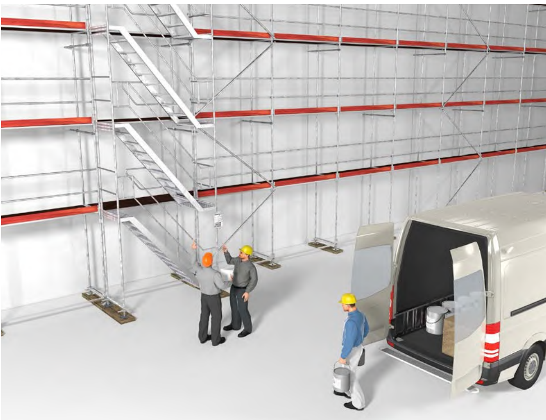
Abb. 91 Gerüst vor Verwendung auf offensichtliche Mängel prüfen
