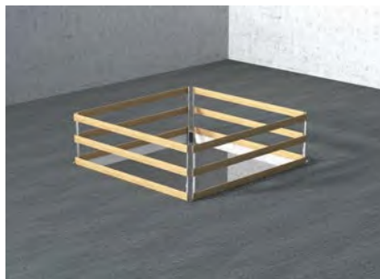
Abb. 79 Sicherung einer Öffnung durch Seitenschutz
