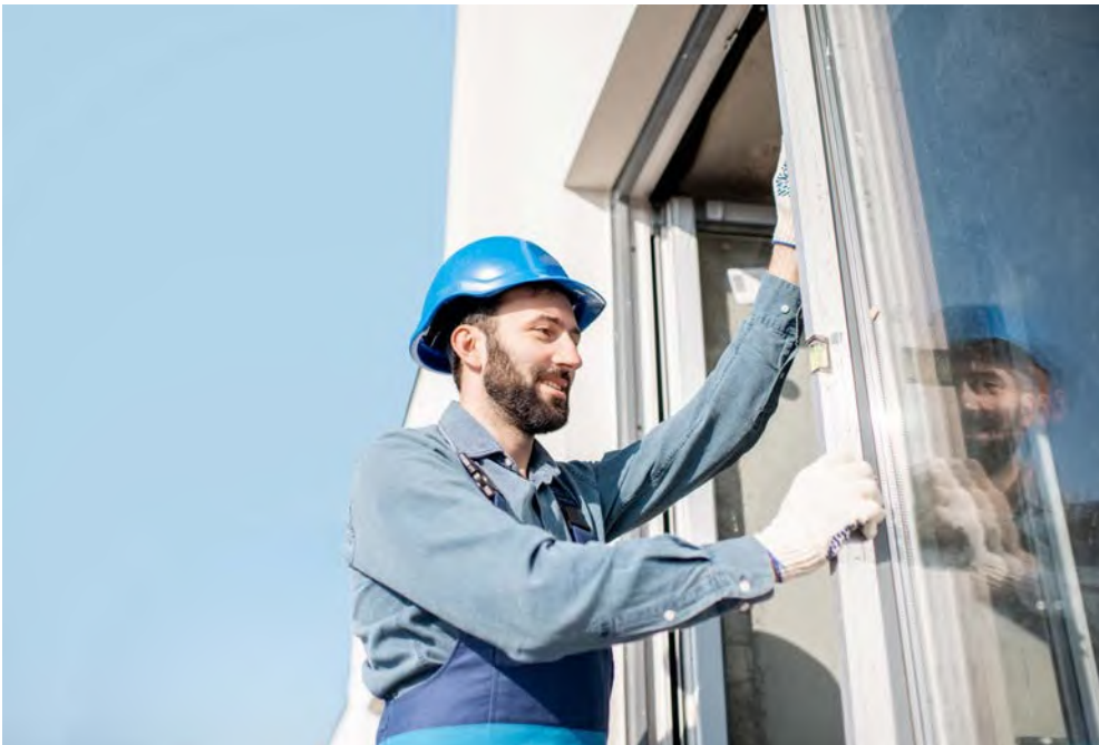
Abb. 77 Montagearbeiten auf der Baustelle
