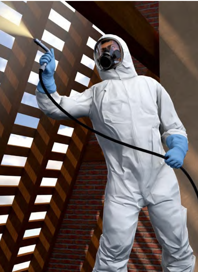
Abb. 18 Arbeiten mit Chemikalienschutzanzug
