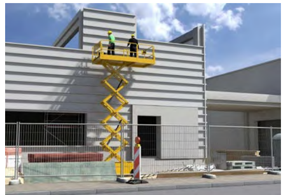
Abb. 97 Profiltafelmontage an der Fassade
