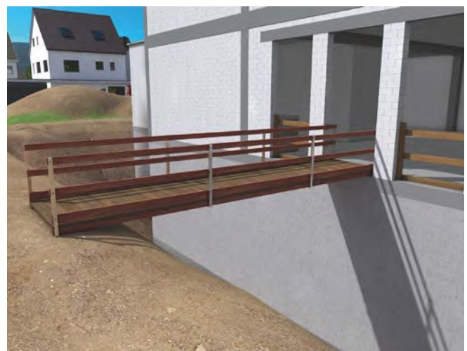
Abb. 81 Laufsteg mit Seitenschutz als Verkehrsweg
