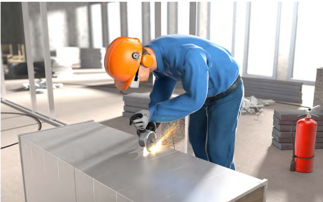
Abb. 4 Lärmarbeit – Schneiden von Metall
