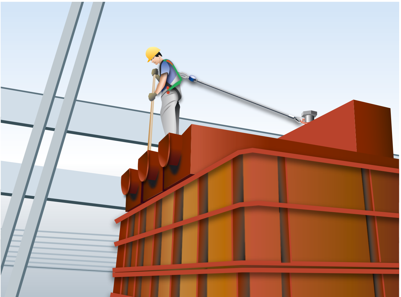
Abb. 18 Absturzsicherung auf Formkästen
