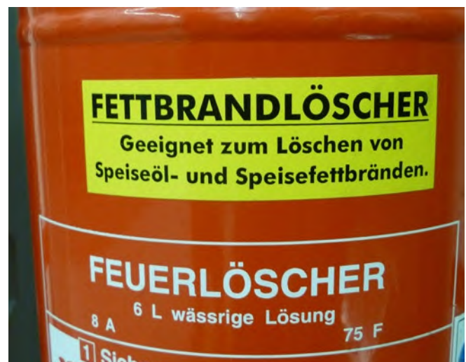
Abb. 12 Kennzeichnung eines für Fettbrände geeigneten Feuerlöschers
