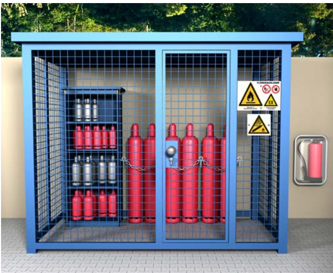
Abb. 32 Lagerung von Flüssiggasflaschen im Freien
